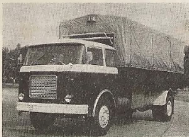
Skoda 706 MTC 5 Lux — nákladní automobil ŠKODA 706 nové typové řady MT určený pro mezinárodní kamionovou dopravu zboží odpovídá předpisům o celním zajištění nákladů.
