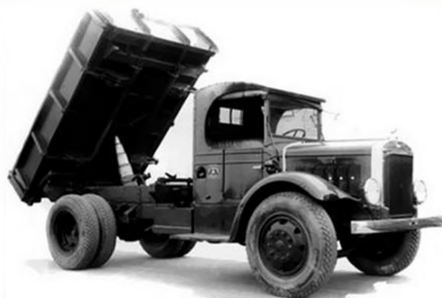
Американский 5-тонный самосвал «ММ» с гидравлическим подъемником, продолжавший эксплуатироваться в НАТИ в 1935–1940 годах
