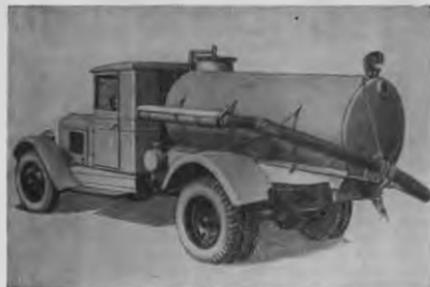
Рис. 2. Ассенизационная машина АСМ на шасси автомобиля ЗИЛ-5
