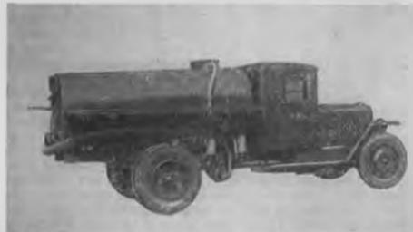
Рис. 3. Ассенизационная машина ЦН-15 на шасси автомобиля ЗИЛ-5
