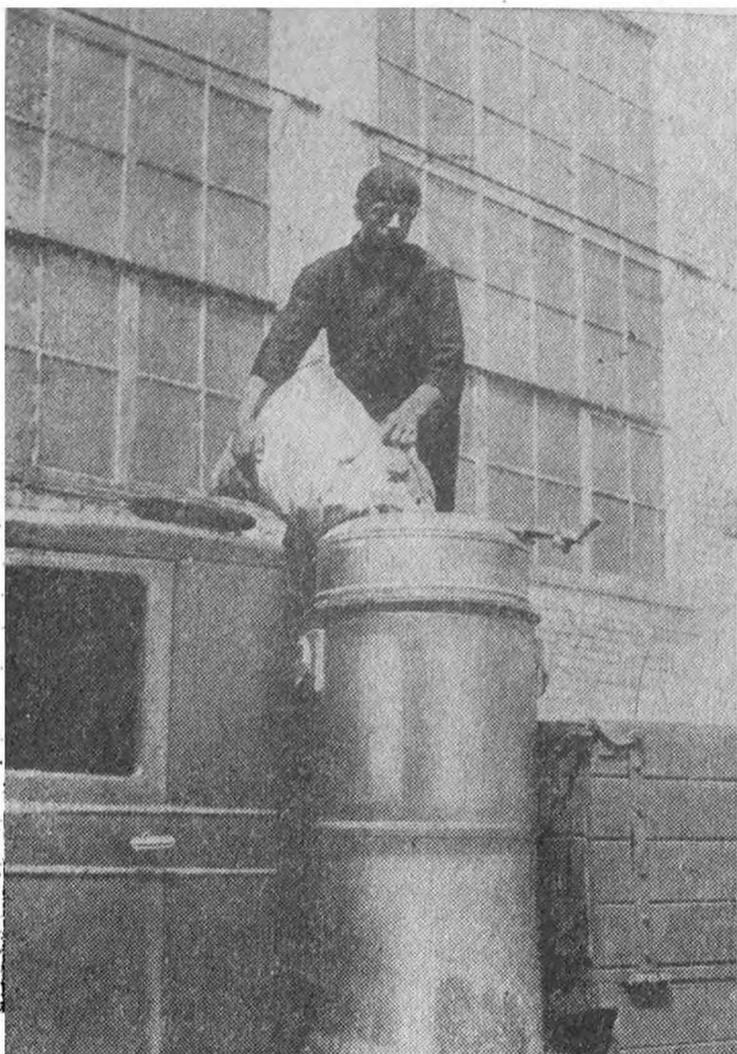
Рис. 26. Загрузка газогенератора топливом.
