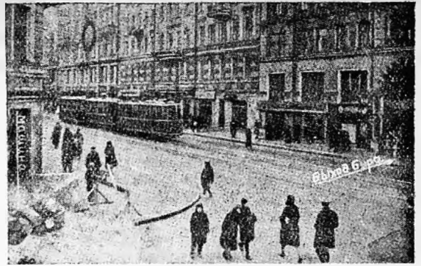
Рис. 7. Подземный переход через улицу шириной в 23 м
