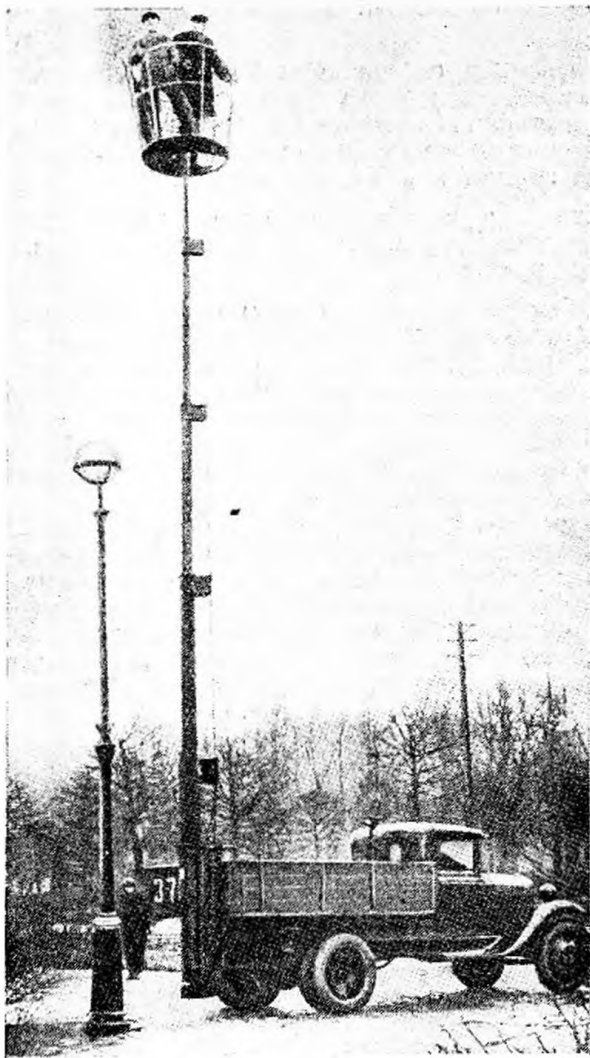
Рис. 4. Общий вид телескопической вышки для коммунальных работ, поднятой на 12 м
