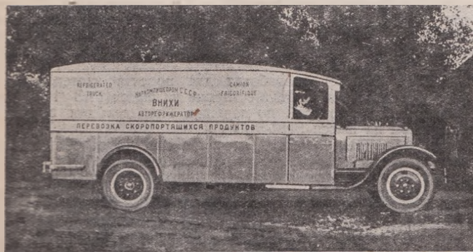
Рис. 8. Авторефрижератор ВНИИ универсальный на шасси АМО-4 с ледо-соляным охлаждением.
