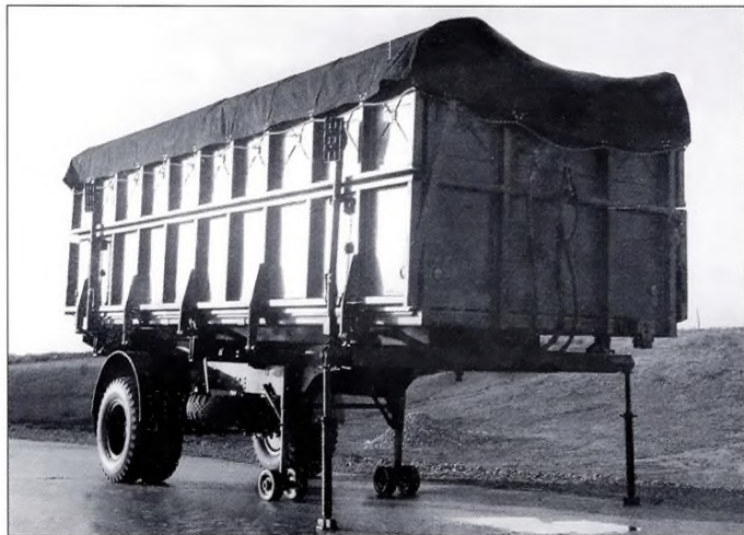
▲ Полуприцеп для перевозки хлопка-сырца КАЗ-716
