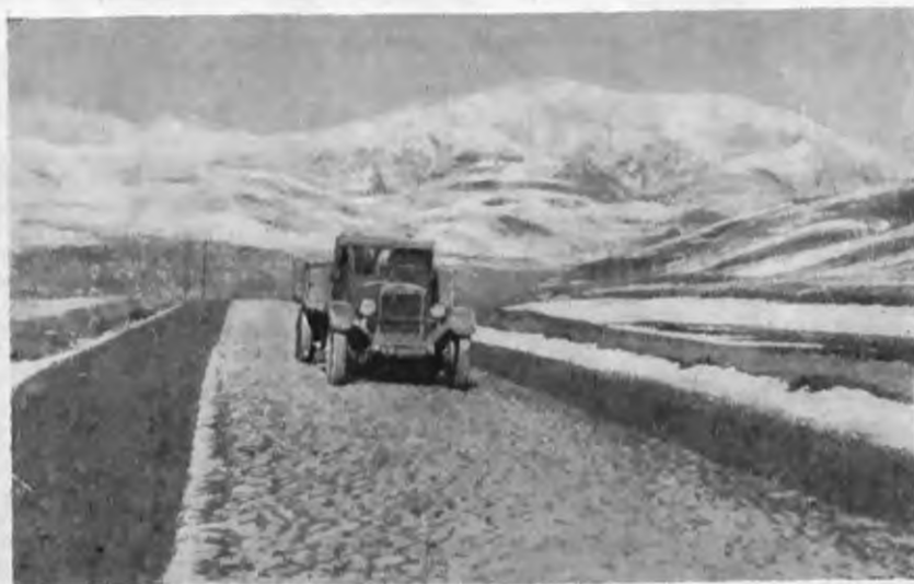
Отдаленные районы и кишлаки Таджикистана связываются новыми десятками тысяч километров благоустроенных шоссейных дорог. На снимке — шоссейная дорога из Сталинабада в Ворзавский район, проходящая через горы
