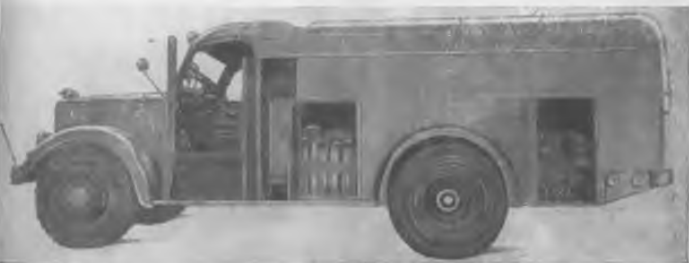
Рис. 57. Вид автоцистерны с открытыми дверцами (левая сторона).
