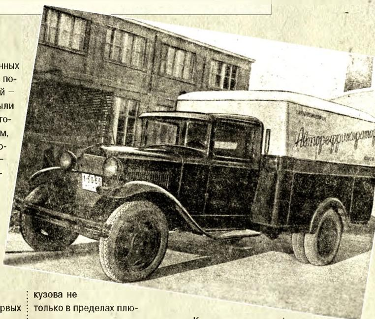
Автомобиль-рефрижератор с пропан-бутановым охлаждением на шасси ГАЗ-АА, 1938 г.
