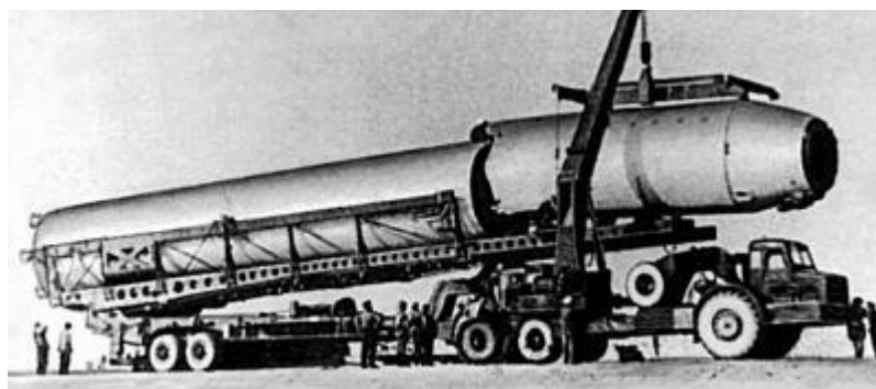
Транспортно-установочный агрегат 8Т178 ракеты Р-36 и перегрузочный кран 8Т26. 1967 год
