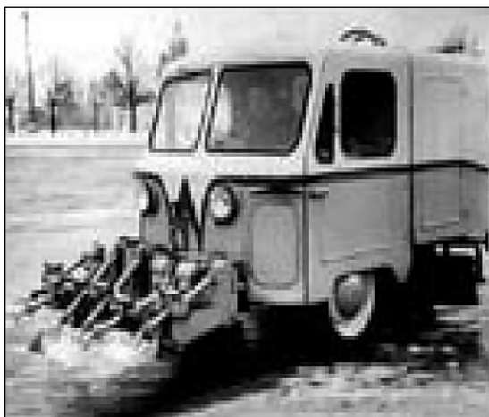
Рис. 3. ТУМ Т-1-СК со скалывателем льда
