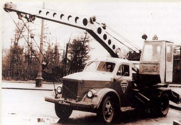
>>> К-2,5-1Э применялся в основном в сельском строительстве
