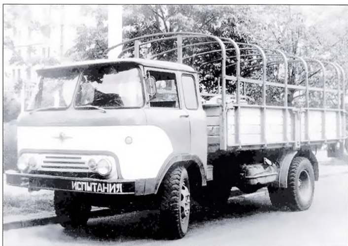
« Автомобиль КАЗ-605 с установленными в кузове стойками для тента. Фото А. Новикова
