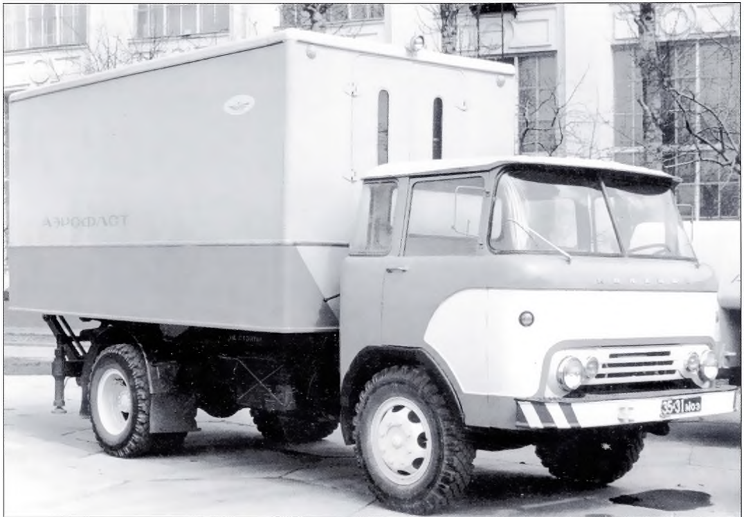
▲ А с 1968 по 1971 г. опытным заводом № 85 ГА на удлиненном шасси КАЗ-608 «Колхида» с базой 3500 мм изготавливались аэродромные автолифты АЛ-3. На снимке машина 1968 г. выпуска. Фото А. Новикова
