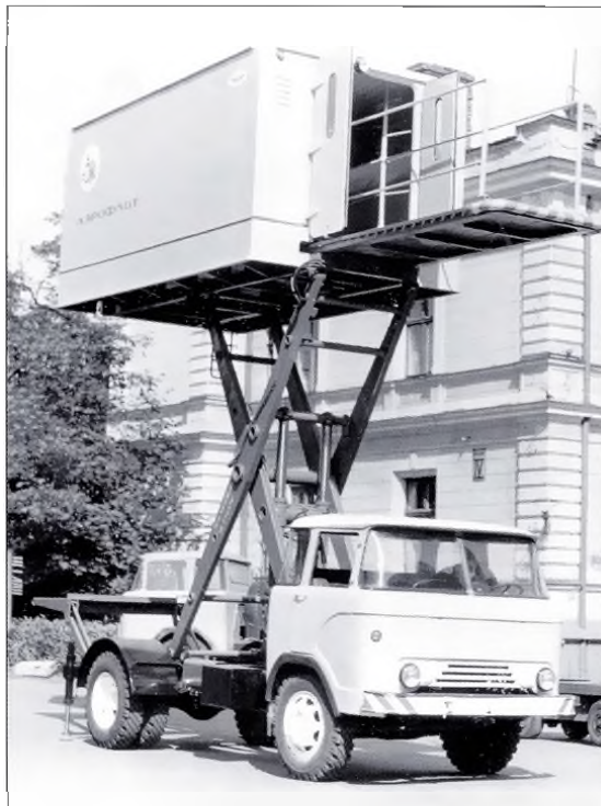
▲ А с 1968 по 1971 г. опытным заводом № 85 ГА на удлиненном шасси КАЗ-608 «Колхида» с базой 3500 мм изготавливались аэродромные автолифты АЛ-3. На снимке машина 1968 г. выпуска. Фото А. Новикова
