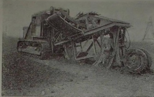
Рис. 4. Экскаватор ЭР-4 в работе
