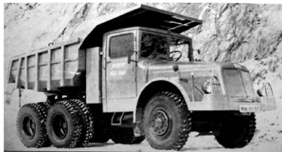
Na extrémně zkráceném podvozku se montovalo provedení Tatra 111 DC5, což znamenalo „dumpecar“. Byl to robustní a obratný jednostranný sklápěč, určený pro práci v povrchových dolech nebo na velkých stavbách socialistů, jako třeba budování přehrad. Světlová ocelová kostra měla tvrdí pruty pod bagrem masivní ochranný štít, chránila kabinu. Hodně těchto vozů se v tehdejší době exportovalo, zejména do zemí sovětského svazu.
