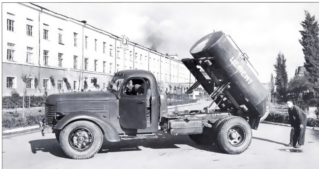
▲ Опытный образец цементовоза КАЗ-601, сфотографированный на территории автозавода в феврале 1955 г. Фото из архива А. Исаева
