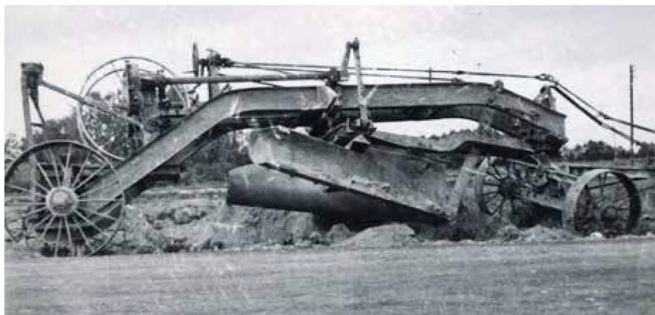
Haagishöövlile monteeritud kraavisahk maanteed kraavimiseks.
