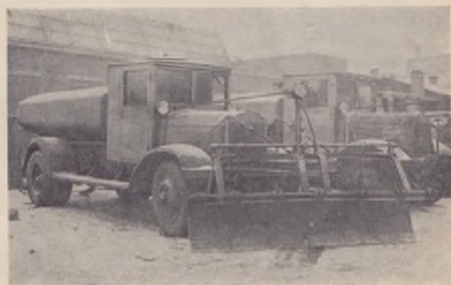
Поливо-моечная машина «ЯГ-6» с большим плугом типа «Гельмерс».
