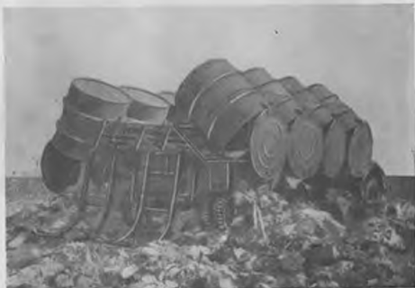
Рис. 14. Выгрузка мусора из контейнеров контейнерной машины МКМ-3.
