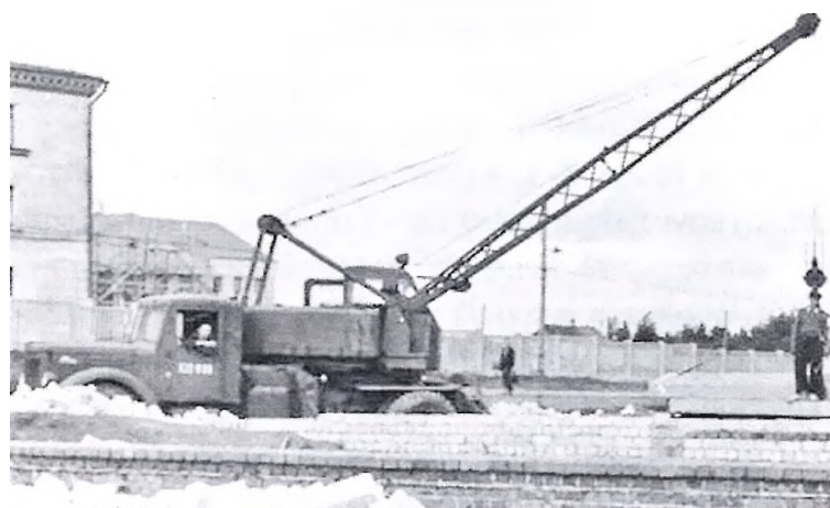
Экземпляр серийного автокрана К-52 на шасси МАЗ-200 1955-1956 гг. выпуска, также еще с двухзначным порядковым номером, но со стандартной стрелой
