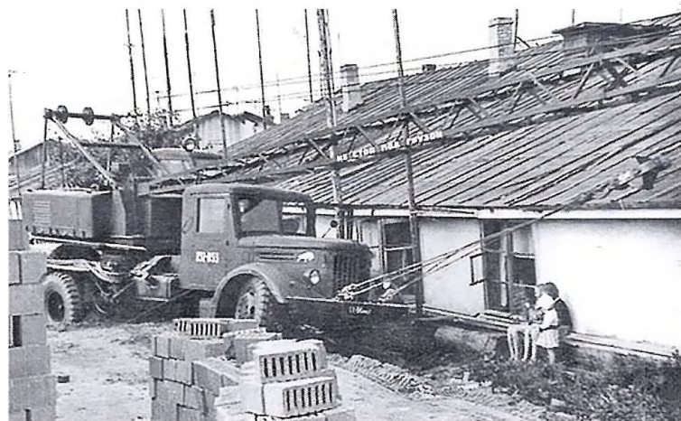
Экземпляр серийного К-52, № 53, с удлиненной стрелой на шасси МАЗ-200 1955-1956 гг. выпуска. г. Красногорск, Московская обл., 1962 г.
