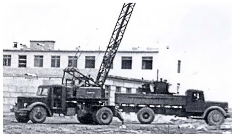
Экземпляр модификации К-52 – автокрана 8Т-211 с удлиненной стрелой (слева) на стройплощадке выгружает оборудование из бортового МАЗ-200
