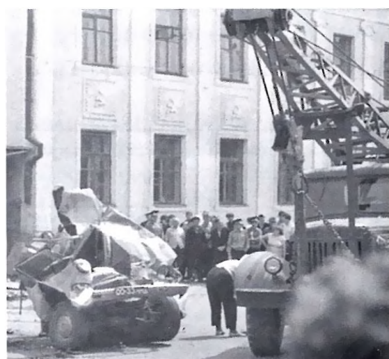
Этот же экземпляр автокрана К-69А с дополнительной стойкой у бампера на шасси МАЗ-200П в процессе погрузки останков «Волги» на платформу бортового УралЗИС-355М. г. Липецк, лето 1966 г.
