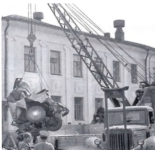
Этот же экземпляр автокрана К-69А с дополнительной стойкой у бампера на шасси МАЗ-200П в процессе погрузки останков «Волги» на платформу бортового УралЗИС-355М. г. Липецк, лето 1966 г.
