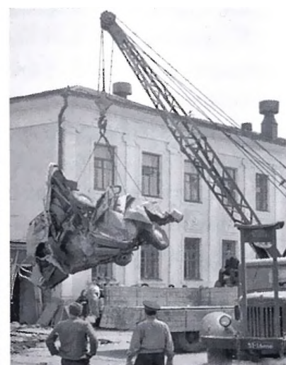
Этот же экземпляр автокрана К-69А с дополнительной стойкой у бампера на шасси МАЗ-200П в процессе погрузки останков «Волги» на платформу бортового УралЗИС-355М. г. Липецк, лето 1966 г.
