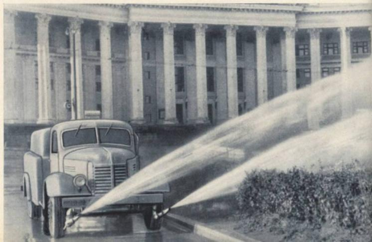
При использовании машины для тушения огня, пожарные рукава с брандспойтами присоединяются к одному или двум концам попечерной трубы.
