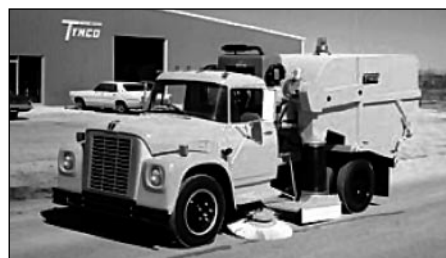
Рис. 17. Вакуумная подметально-уборочная машина модели 600 компании Tutco (1969 г.)
