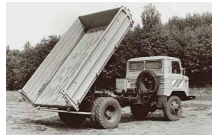
Макетный образец ГАЗ-САЗ-3531 со снятыми надставными бортами; задний борт открыт на нижних петлях
