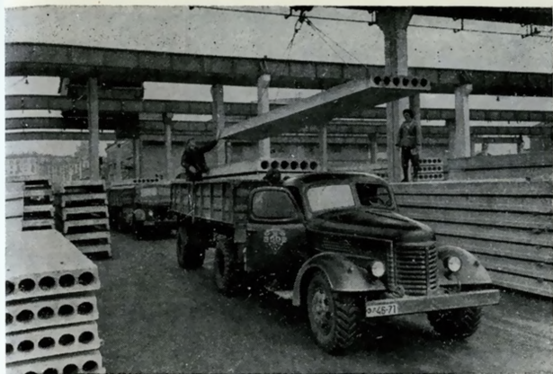
Рис. 8. Погрузка панелей в горизонтальном положении на автомобиль.
