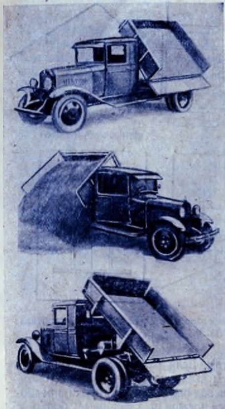
Фиг. 48. Самосвал ведущий разгрузку на три стороны.
