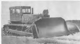
Фиг. 3. Бульдозер Д-275 с упирателями на тракторе Т-140.
