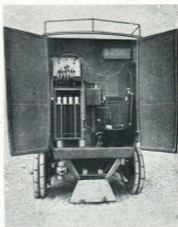
Рис. 82. Радио-станція Делаже (отдѣленіе приборовъ высокой частоты и высокого напряженія).
