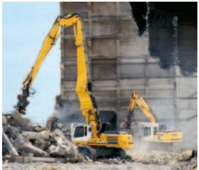
Der robuste, groß dimensionierte Unterwagen des Gerätes sorgt durch seine Gesamtbreite von 3.330 mm für eine optimale Standsicherheit, wichtig bei der Arbeit in großen Höhen. Für den Straßentransport lässt sich der hydraulisch verstellbare Unterwagen auf lediglich 2.380 mm Breite reduzieren.
