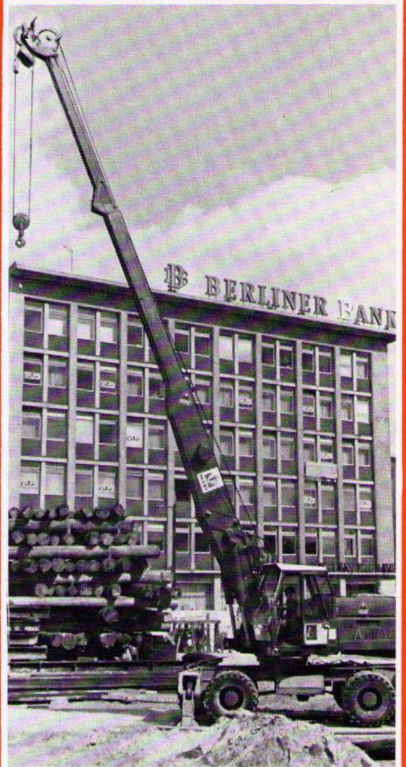
Bagger mit Kranarm und Seilwinde
