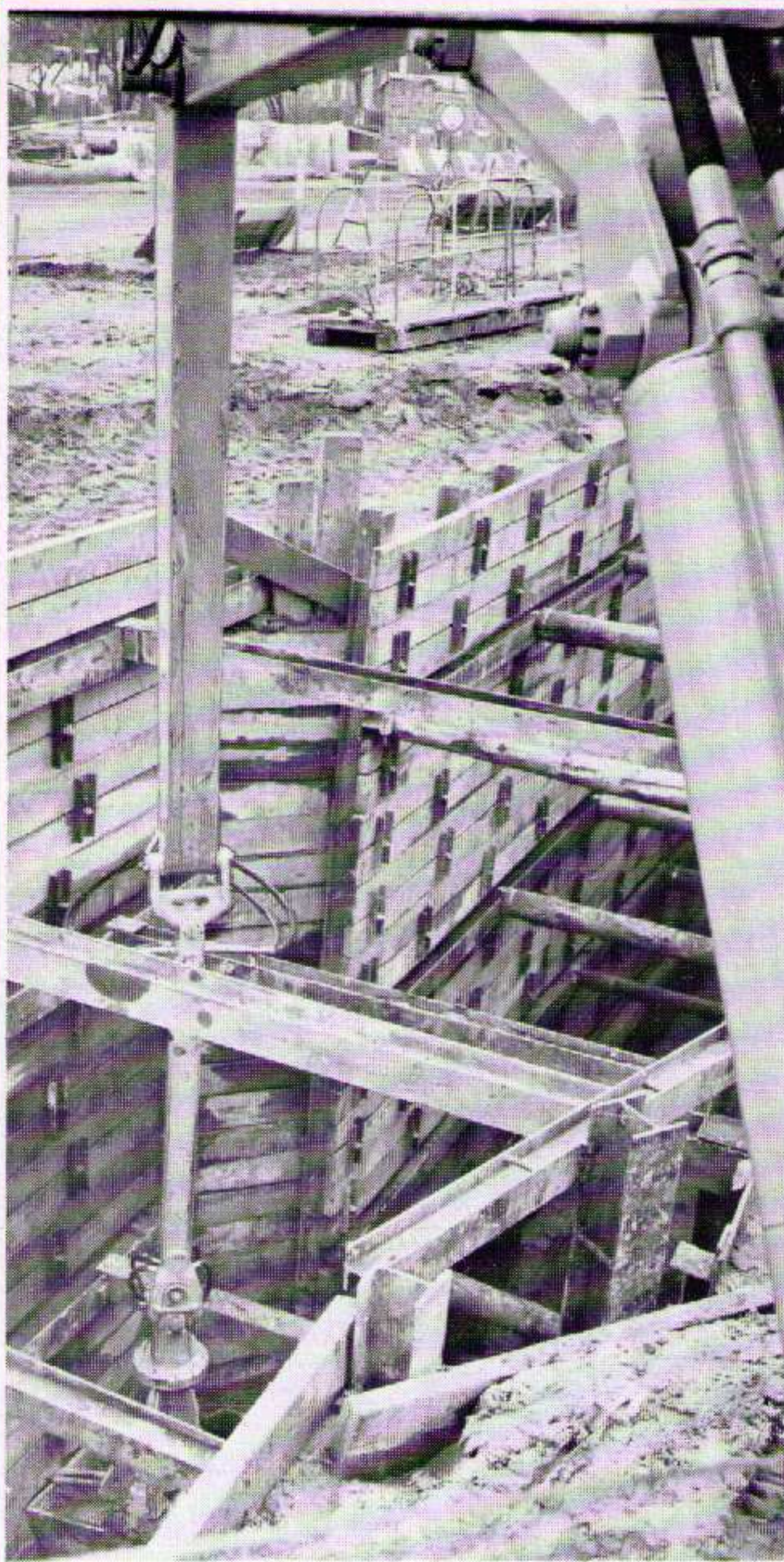
Tiefgreifeinrichtung im Verbau
