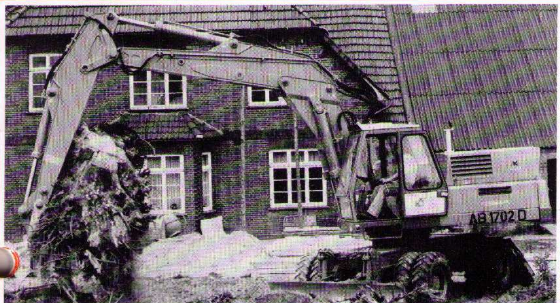
Entfernen von Baumwurzeln mit dem Rodezinken
