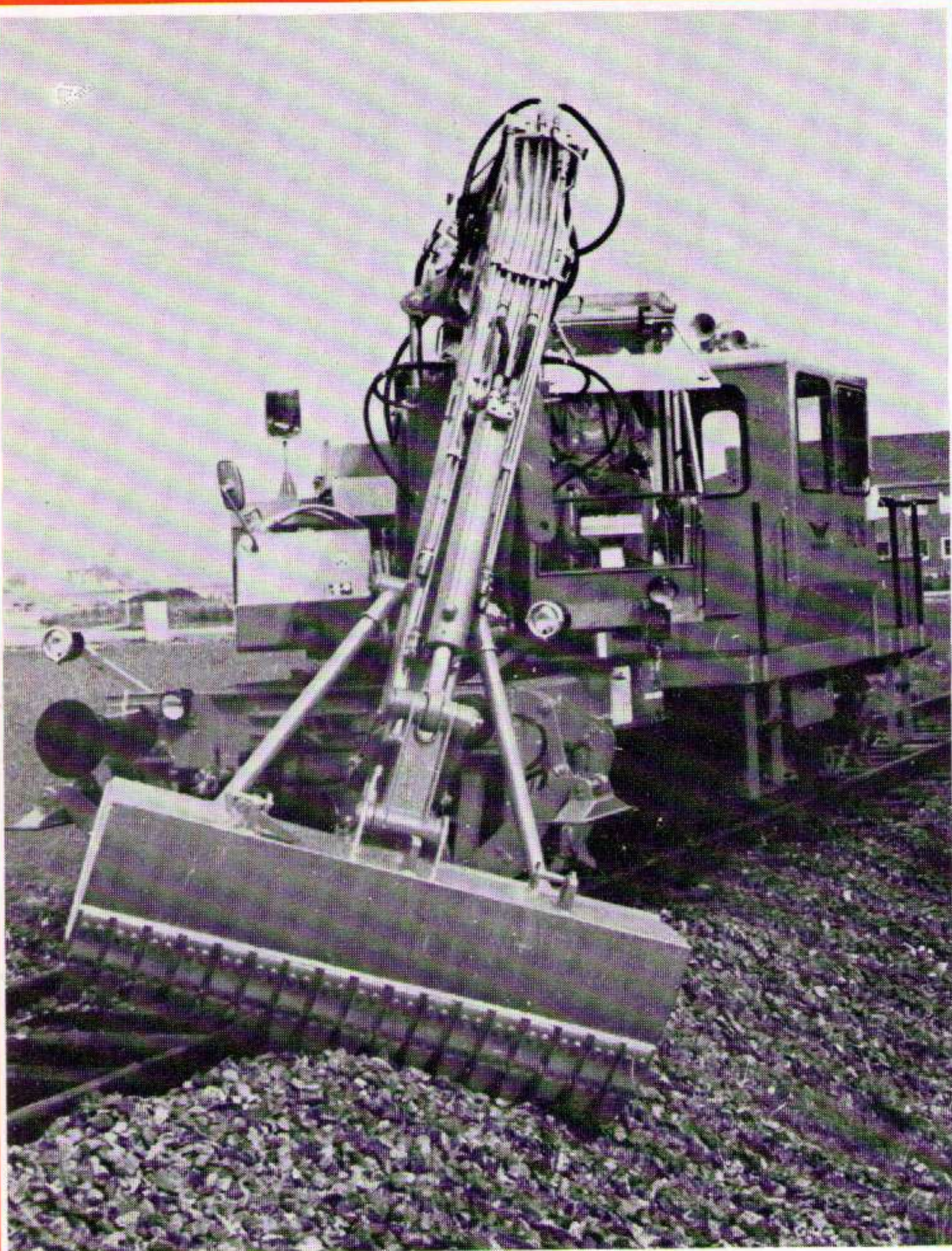
auf Gleisbaufahrzeug für Böschungsarbeiten
