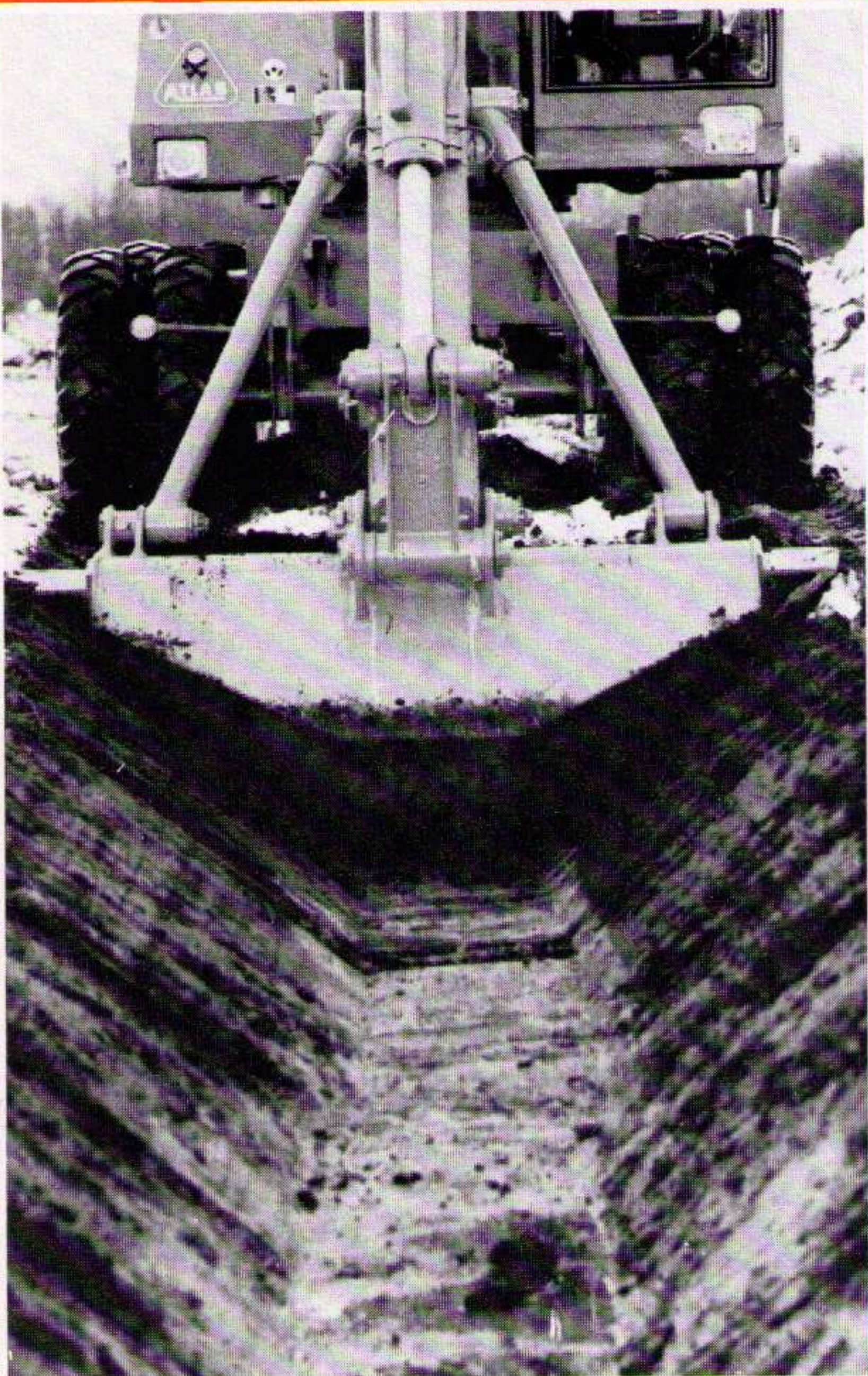
Mobilbagger mit Profilgrabenlöffel
