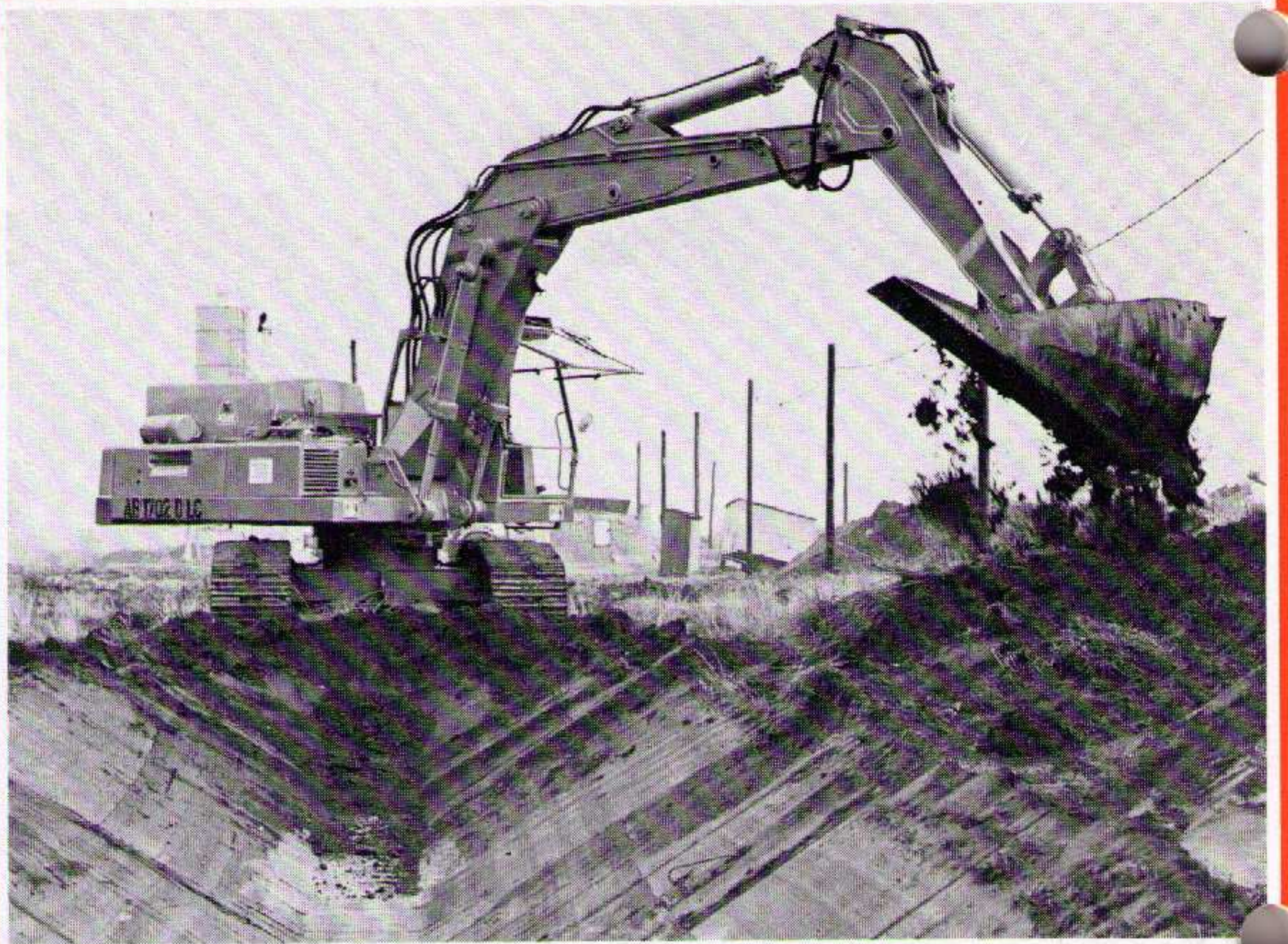
Grabenaushub mit Profilgrabenlöffel
