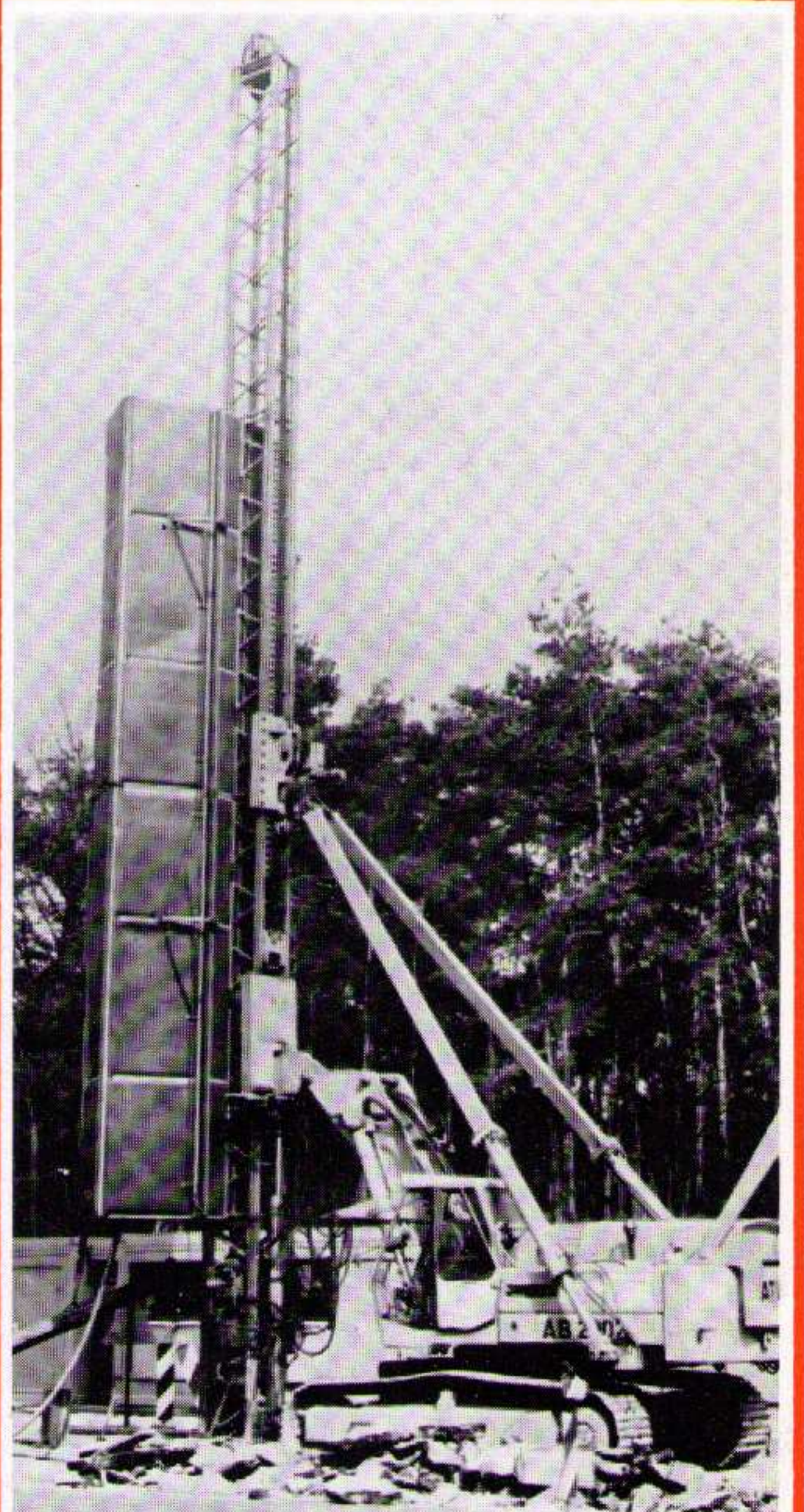
Druckluft-Ramme mit Schallschutz
