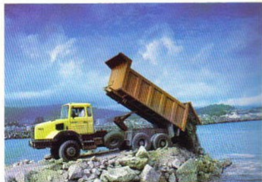
CBH 280: construção portuária em Espanha.
