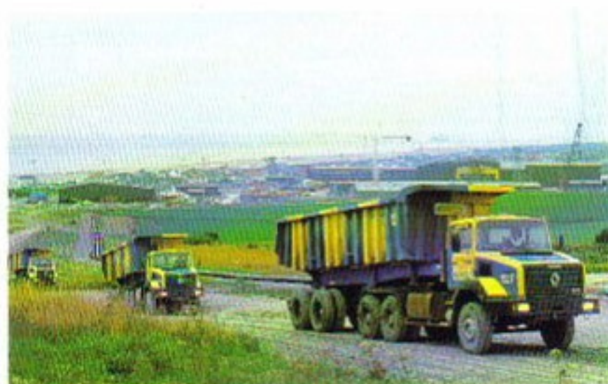
Euro-tunel: trabalho intensivo para os CBH.
