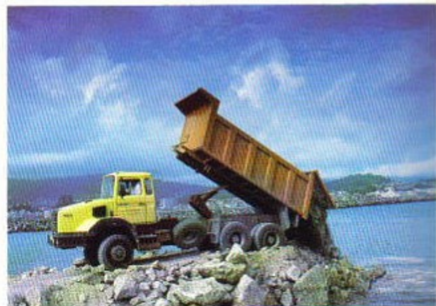
CBH 280: construção portuária em Espanha.
