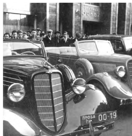
Опытные образцы ГАЗ-11-40 с облицовкой М-1 неоднократно показывали в столице. На переднем плане экземпляр с нетрадиционным для фэзтона цельным ветровым стеклом. Москва, 1939 год.
