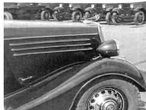
Вместо лувров на капотных боковинах экземпляра № 3 красовались хромированные декоративные горизонтальные пластины. Колесные диски также были экспериментального типа (скорее всего – импортные). Лето 1935 года.
