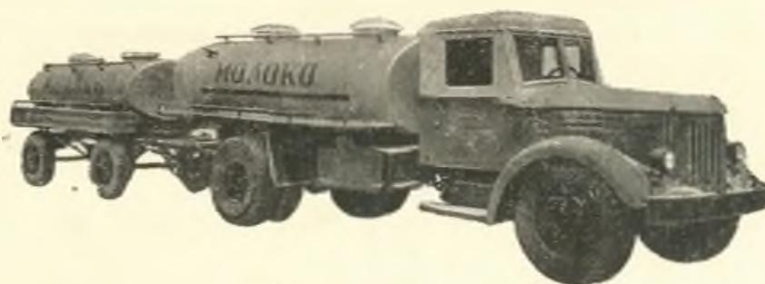
Автомобиль-цистерна АЦ-525 на шасси автомобиля МАЗ-200 предназначен для перевозки молока с районных молочных заводов и крупных заготовительных пунктов на городские молочные заводы.
