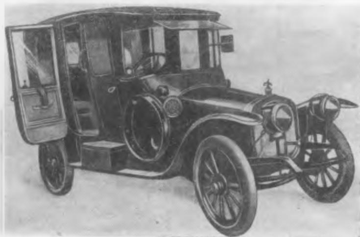
Рис. 9. Автомобиль «Руссо-Балт» с кузовом типа берлина (седан)
