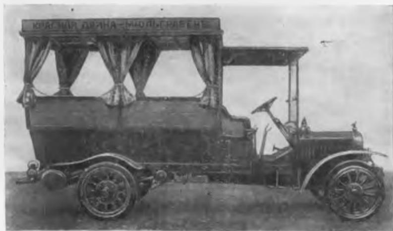
Рис. 15. Омнибус «Руссо-Балт» на шасси грузового автомобиля модели М (1913 г.)
