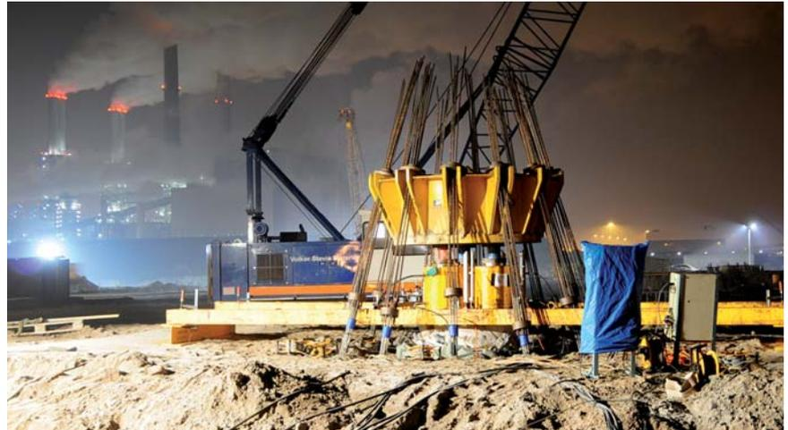
Испытание свай в Роттердам-Маасвлakte для угольной электростанции E.ON
