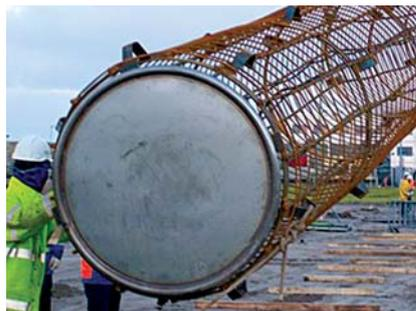
Технология Bauer Lift-Cell для предварительного напряжения в зоне свайной пяты
