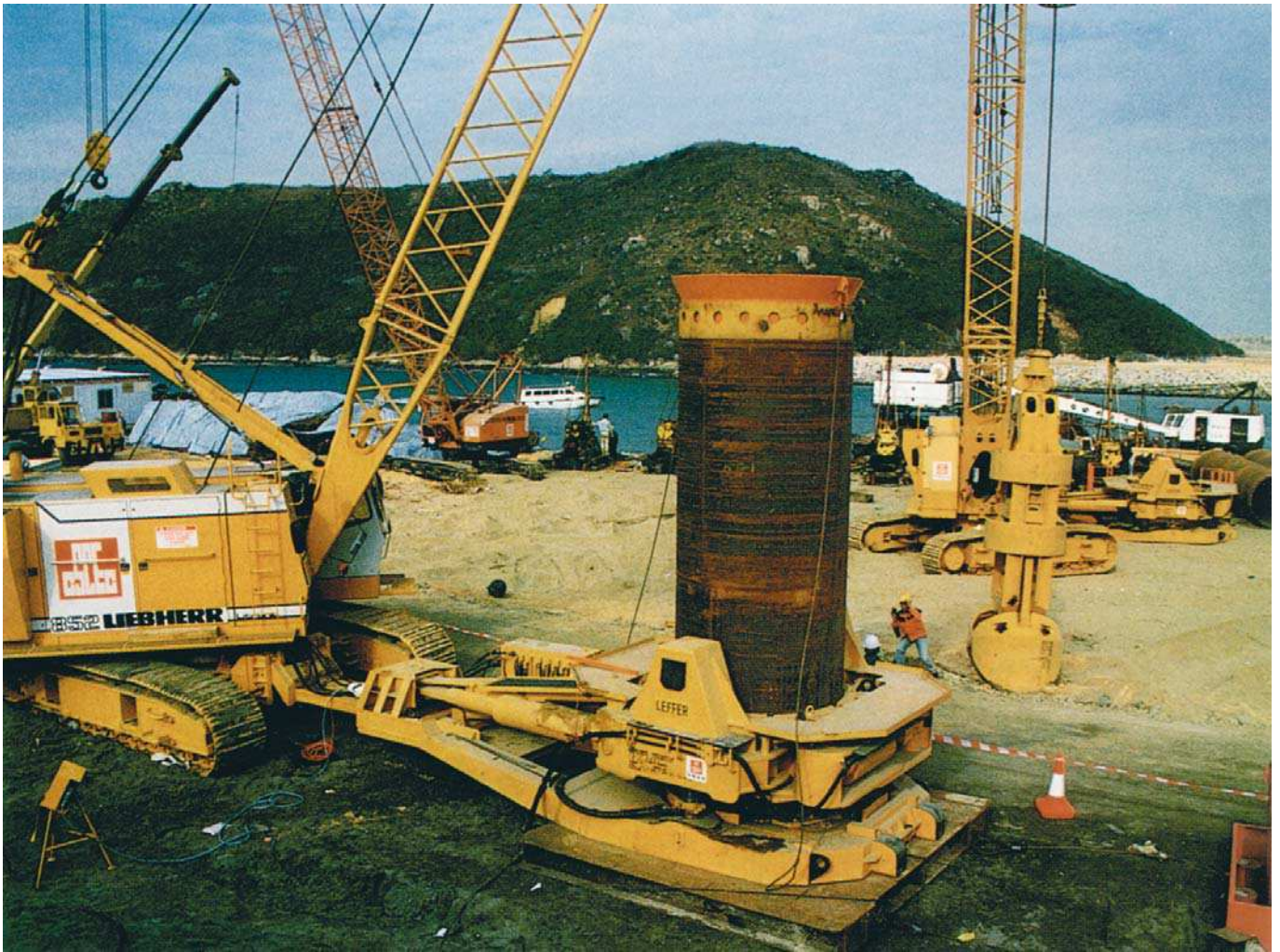
Verrohrungsmaschine \varnothing 2000 mm im Einsatz in Hong Kong Machine hydraulique de forage, \varnothing 2000 mm de diamètre, en service à Hong Kong Hydraulic casing oscillator, \varnothing = 2000 mm in operation in Hong Kong
