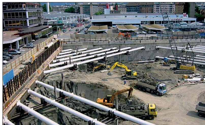
Baugrube Rolex Genf mit Aussteifungen
