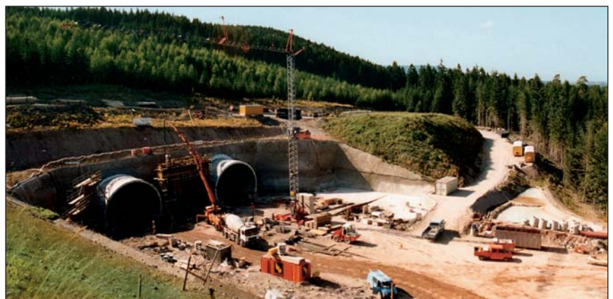
Autobahn-Tunnel Alte Burg im Thüringer Wald
