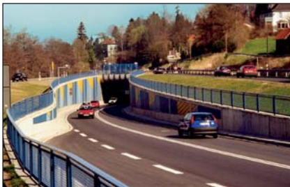
Unterführung B 462 bei Gernsbach
