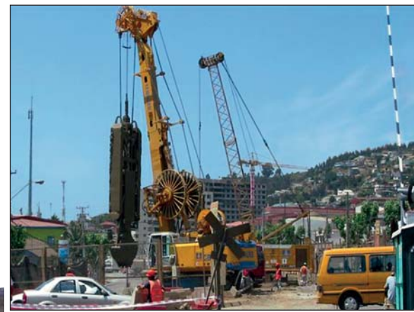
Schlitzwand für Bahn-Tieferlegung in Vina del Mar, Chile
