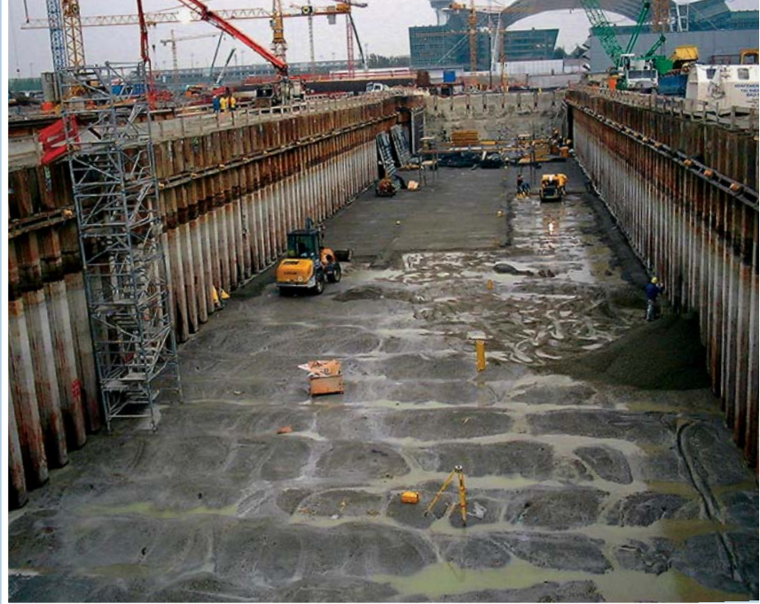
Baugrube, deren horizontale Abdichtung als Unterwasserbeton-Sohle hergestellt wurde.
