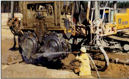
Bauer-Schlitzwandfräse BC 30 beim Bau der Schleuse Hohenwarthe
