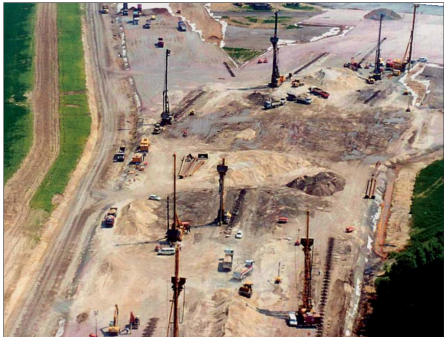
Rüttelstopfverdichtung am Autobahnkreuz Leipzig-Süd A 38
