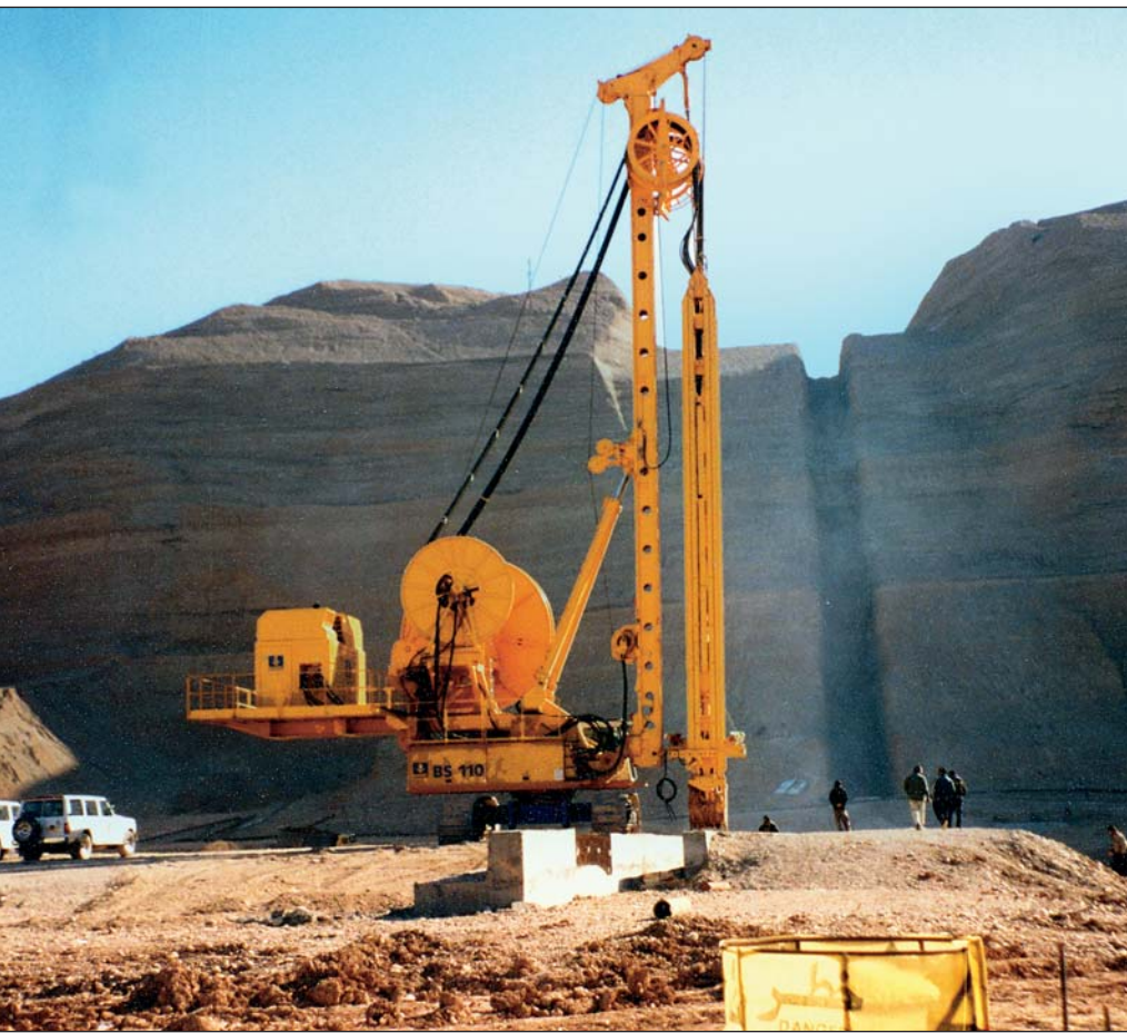
Vertikale Untergrundabdichtung für den Karkheh-Damm im Iran
