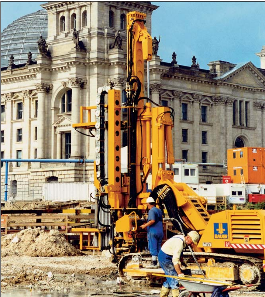
Abbohren von GEWI-Pfählen zur Auftriebssicherung in der Baugrube Marie-Elisabeth-Lüders-Haus neben dem Reichstag
