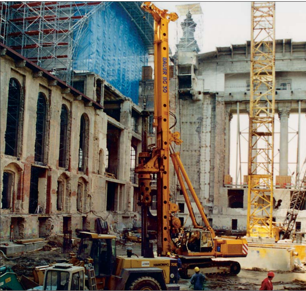
Umfangreiche Nach Gründungsarbeiten ermöglichen neue Nutzung im Reichstag.
