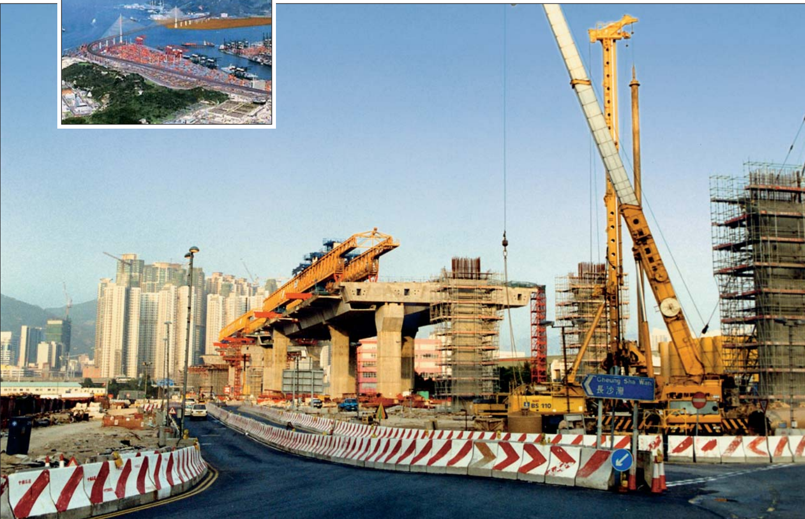
Gegründet auf Bauer-Pfählen führen die hochgeständerten Straßen durch Bangkok.
