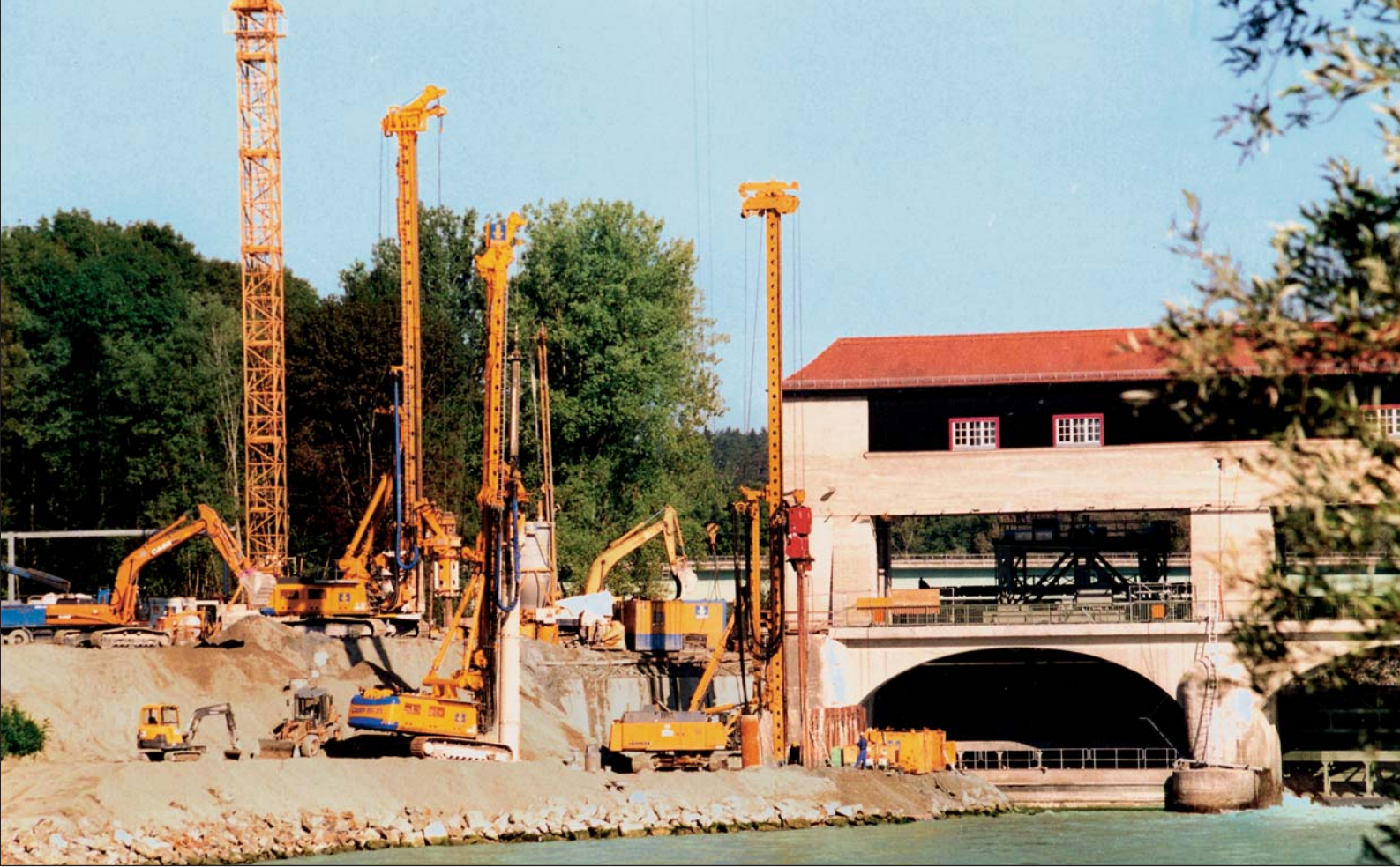
Erweiterung E.ON-Kraftwerk bei Jettenbach am Inn: Herstellung der Baugrube mit Bauer-Großdrehbohrgeräten
