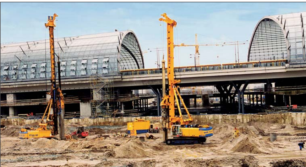
Herstellung einer tiefliegenden horizontalen Dichtsohle – Lehrter Bahnhof Berlin
