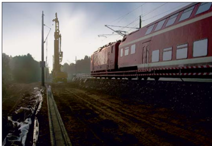
Fahrdammstabilisierung bei Müssen
