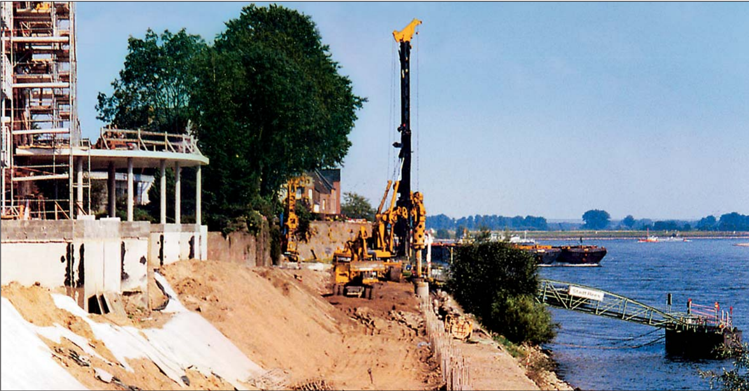
Herstellung der Uferbefestigung für den Hochwasserschutz der Stadt Rees am Niederrhein
