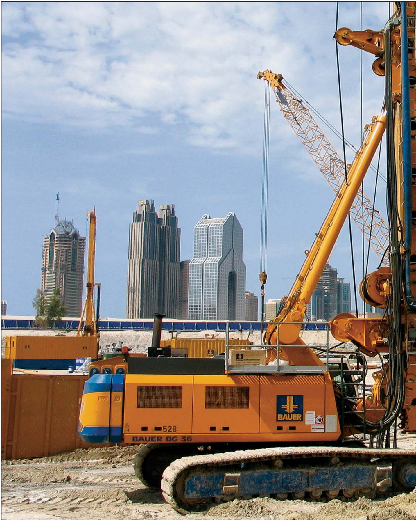
Gründungsarbeiten für den Burj Dubai
