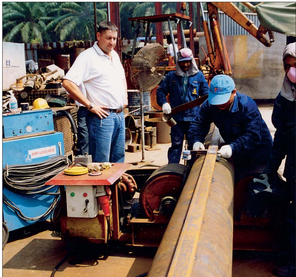
Kelly-Schweißerei am Werkhof von Bauer Spezialtiefbau in Kuala Lumpur
