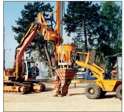
Bodenverbesserung mit CSV-Säulen
