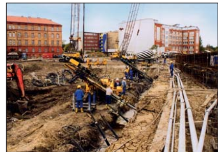
Rückverankerung der Schlitzwand
