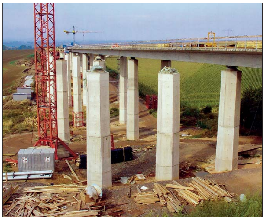
Schachtbau Nordhausen baute die Hungerbachtal-Brücke auf der Neubaustrecke A 38.
