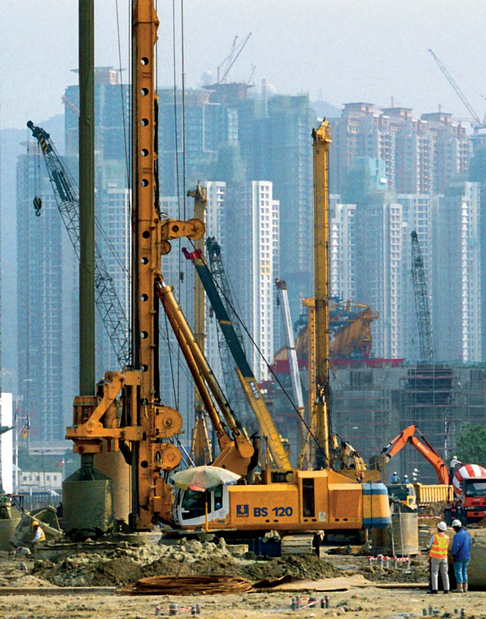
Pfähle mit 2,5 m Durchmesser bis 85 m Tiefe für aufgeständerte Auffahrt der Route 8 in Hongkong
