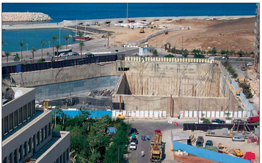
Baugruben an der Corniche von Beirut
