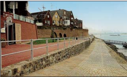
Herstellung der Uferbefestigung für den Hochwasserschutz der Stadt Rees am Niederrhein
