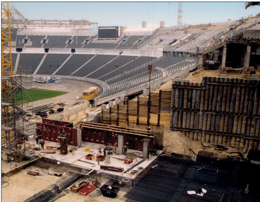
Pfahlwände und große HDI-Maßnahmen halfen zur Modernisierung des Olympiastadions.
