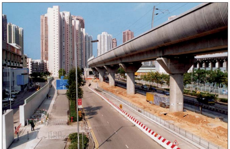
Aufständigung für den Schienen-Nahverkehr in die New Territories – gegründet auf Bauer-Pfählen
