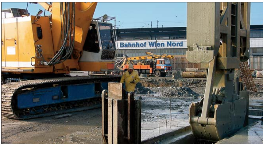
Schlitzwand für Erweiterung der U-Bahn in Wien
