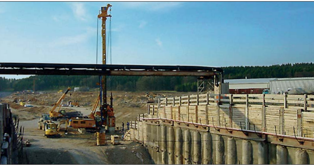
ICE-Neubaustrecke Ingolstadt-Nürnberg bei Denkendorf
