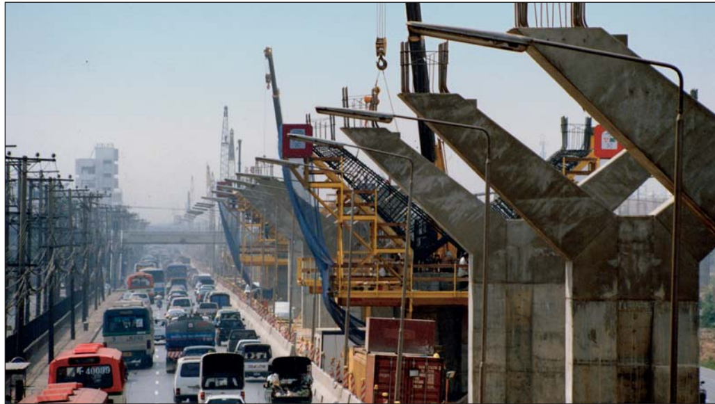
Gegründet auf Bauer-Pfählen führen die hochgeständerten Straßen durch Bangkok.
