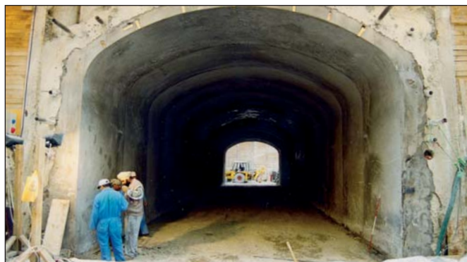
Nach Herstellung des Injektionsschirms wurde der Tunnel freigelegt.
