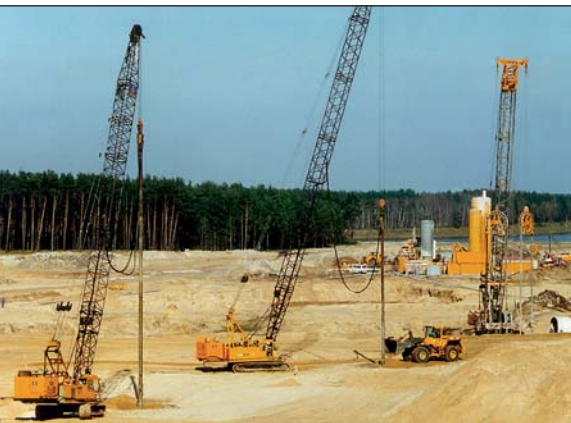
Verdichtung des Baugrunds mit Tiefenrüttler
