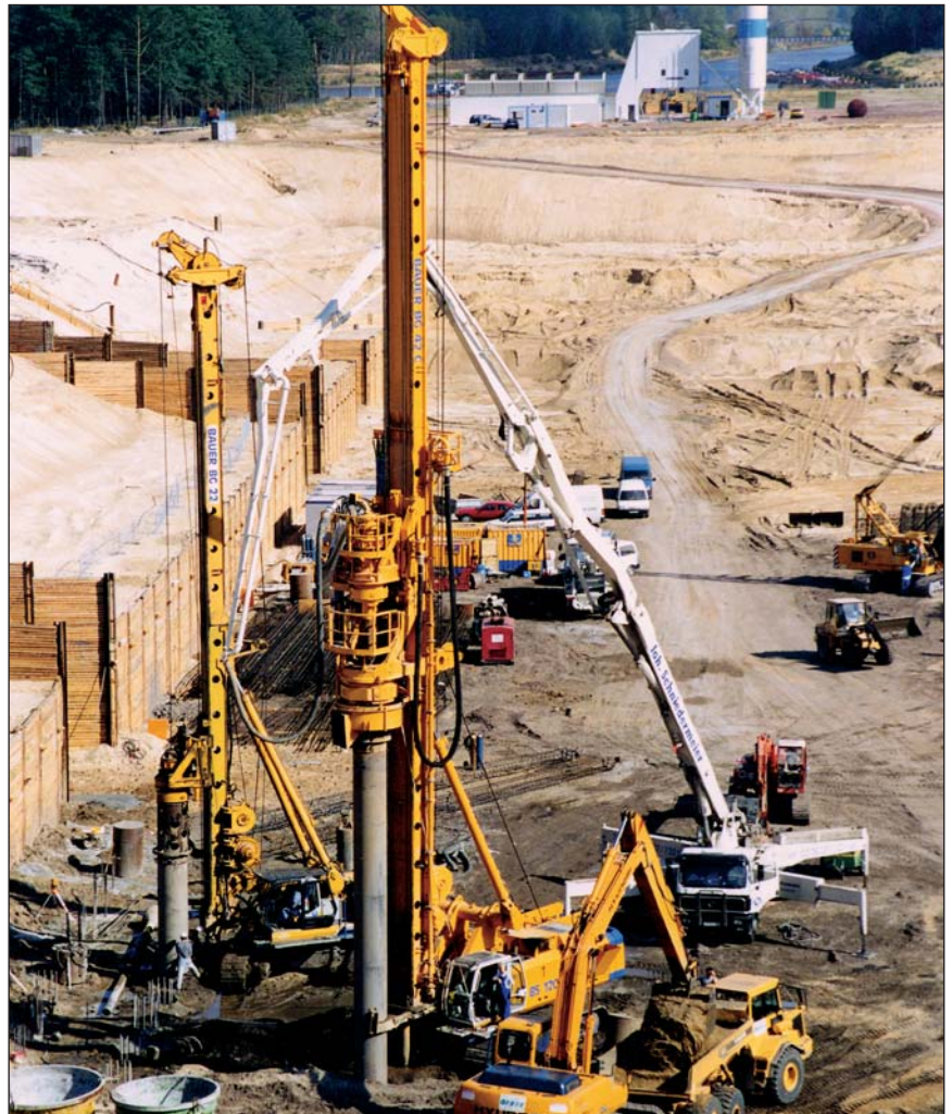
Die Gründungspfähle für die Schleusensole wurden mit Bauer BG 42 hergestellt.
