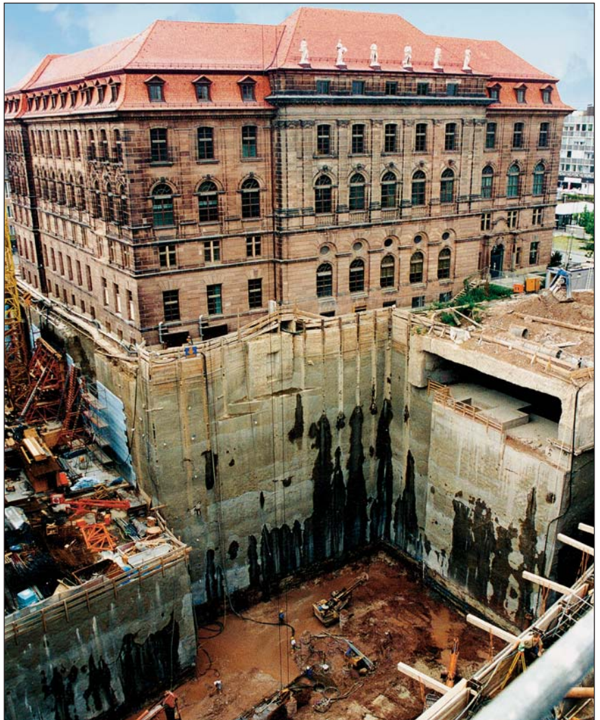
Blick in die 35,5 Meter tiefe Baugrube für das IMAX-Kino
