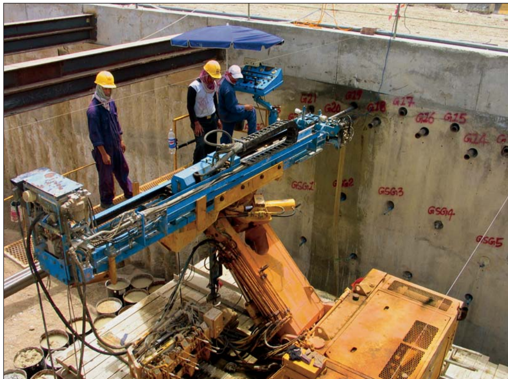
Horizontalbohrung für den Schutzschirm des Tunnels
