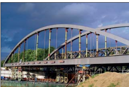
Stahlbrücke aus Schachtbau-Produktion
