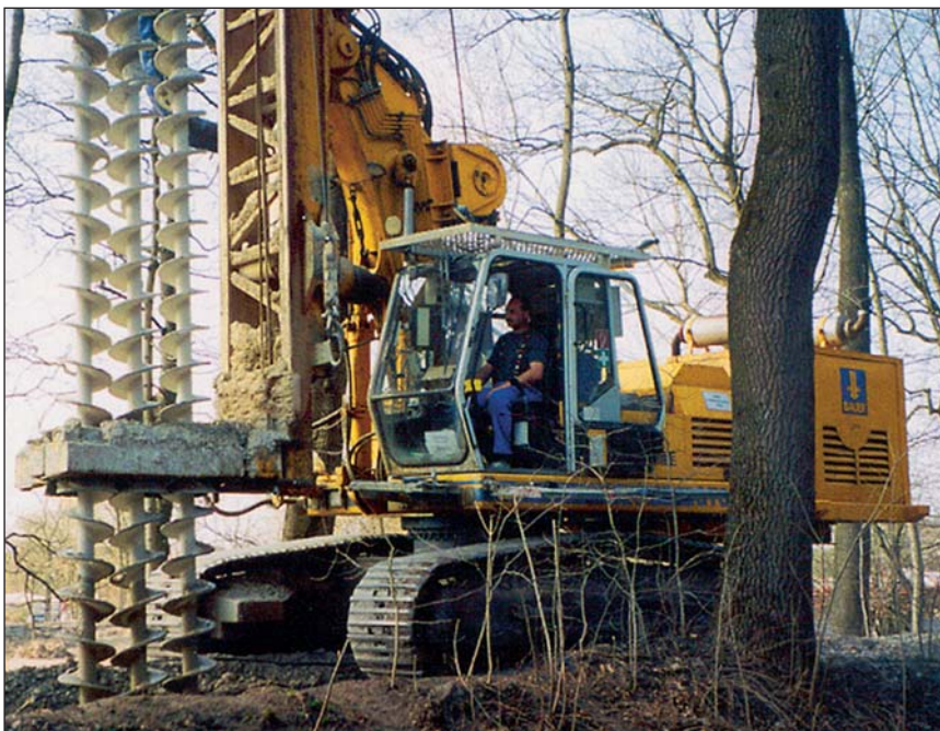
Dichtende MIP-Wand in den Isar-Auen im Münchener Süden
