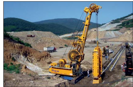
Dammabdichtung in Tabarka, Tunesien
