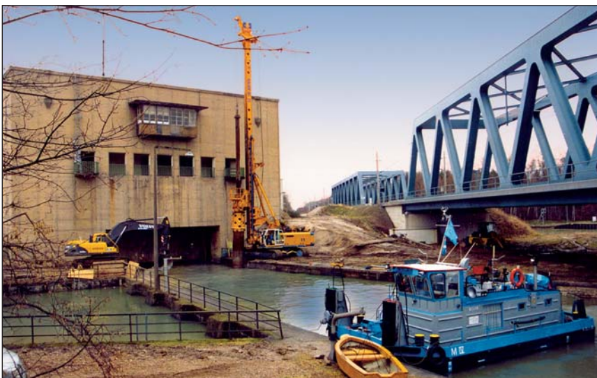
Die Schleuse Sülfeld (unten) wurde für große Schiffverbände ausgebaut.
