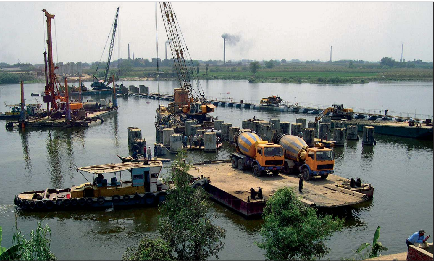
Gründungsmaßnahmen für die Kafr El Zayat Bridge über den Nil
