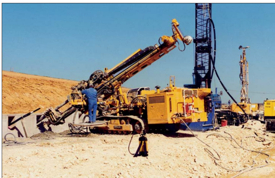
Ankerarbeiten an Böschungen der ICE-Strecke München-Nürnberg
