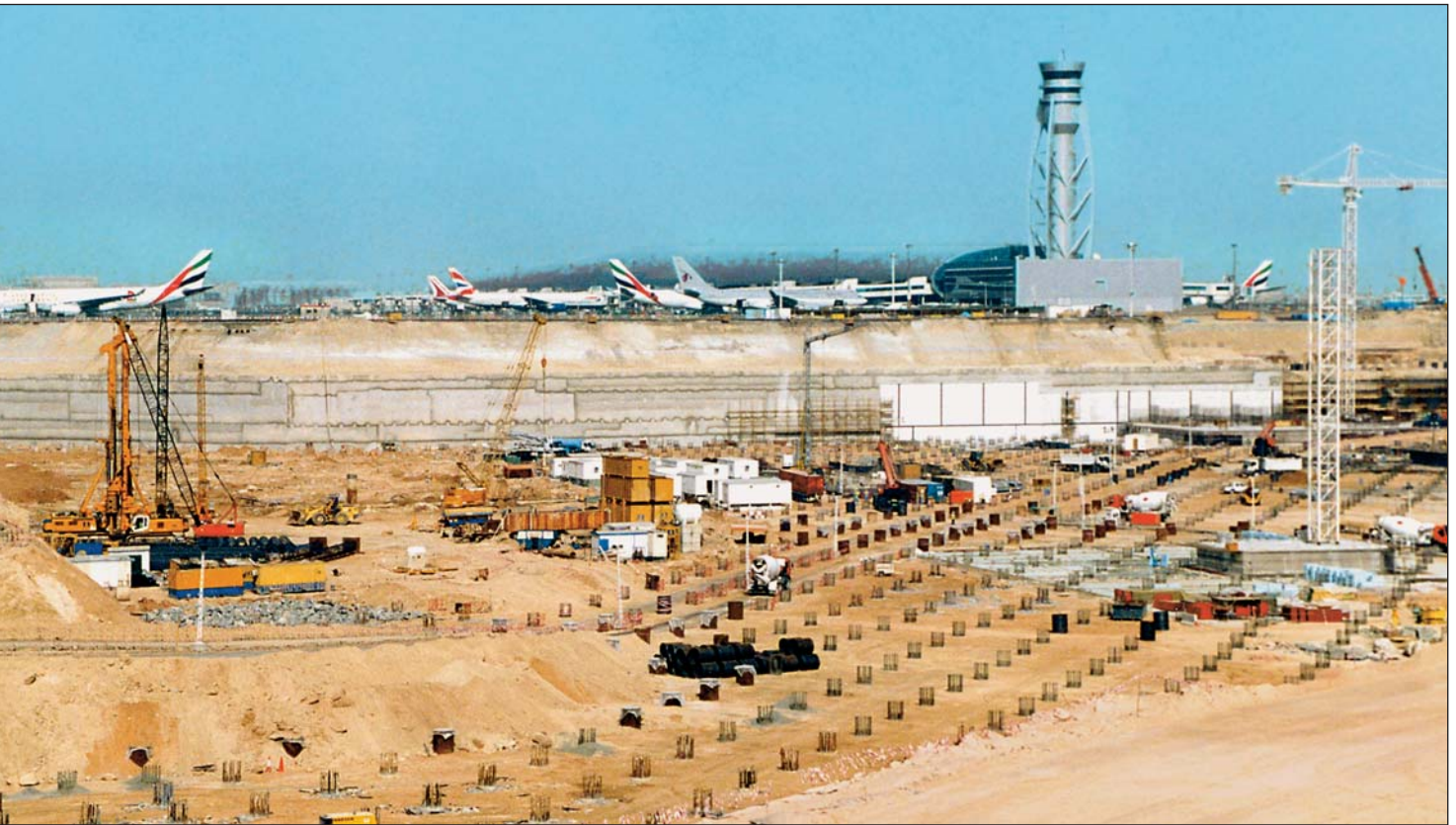
Mit Bauer-Geräten wurden die Gründungspfähle in Dubai abgebohrt.
