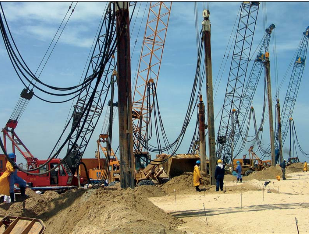
Rüttelverdichtung in Dubai
