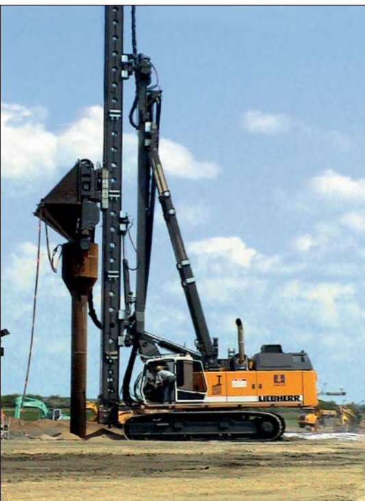
Herstellen von CSV-Säulen für Autobahn A 20 bei Rostock
