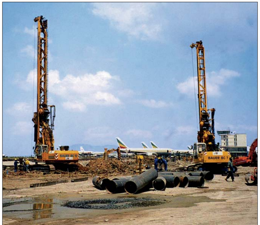
Pfahlarbeiten für ein neues Terminalgelände am Flughafen von Addis Abeba
