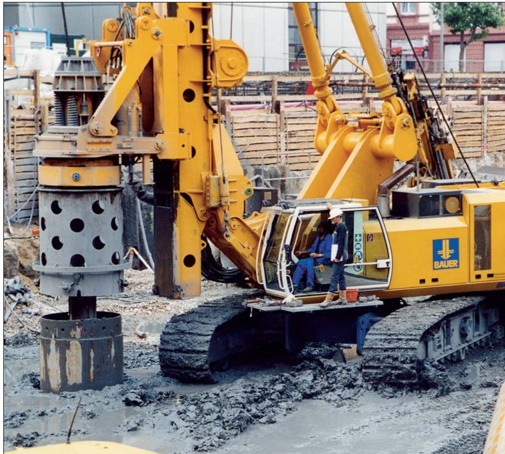
Einsatz der Bauer BG 48 – Gründung des Hochhauses Skyper in Frankfurt
