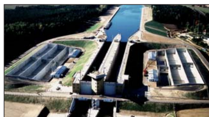
Blick auf die neu erstellte Schleuse
