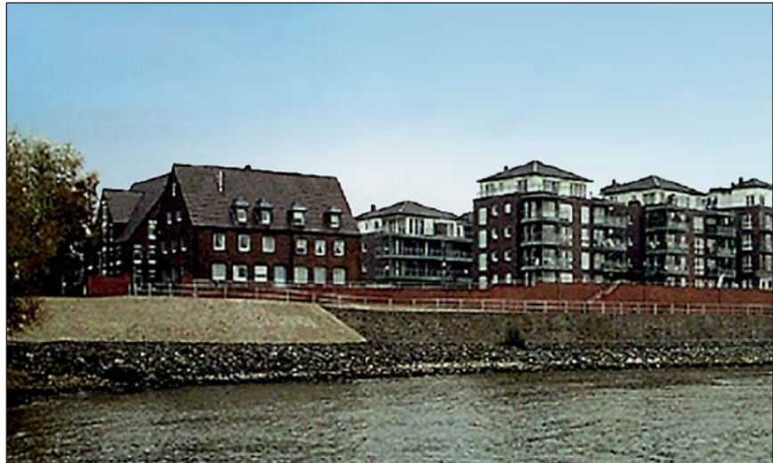
Blick auf Rees und der neuen Verblendmauer nach Abschluss der Bauarbeiten
