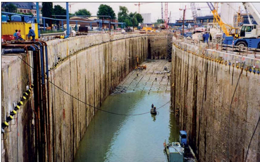
Gelenkte Baugrube für Nord-Süd-Trasse der Bahn im Bereich Lehrter Bahnhof
