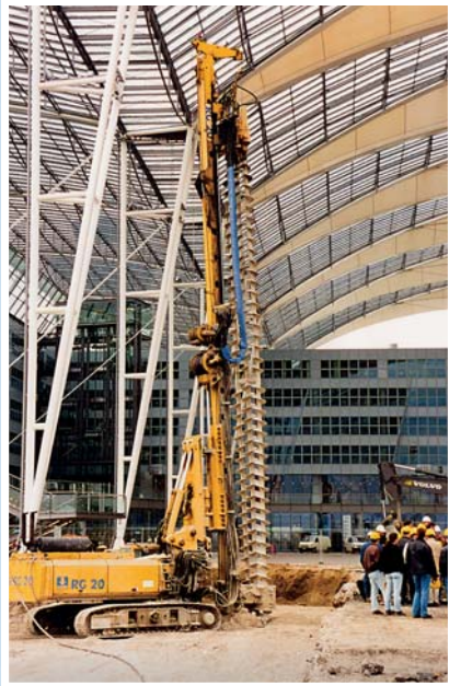
MIP-System Dreifachschnecke
