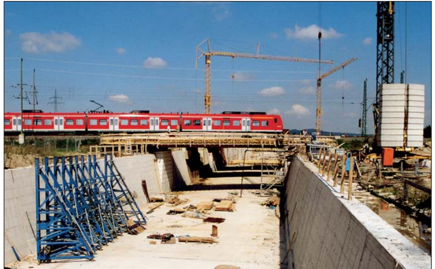
Trog für Unterführung Weetzen
