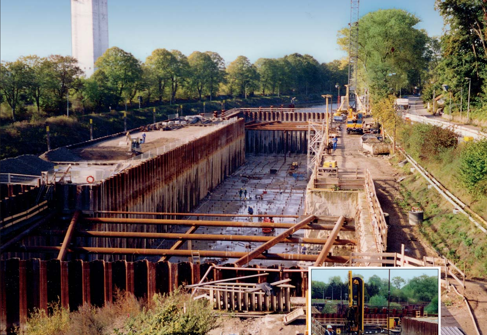
Die traditionsreiche Schleuse Lauenburg wurde neu gebaut (oben und unten).
