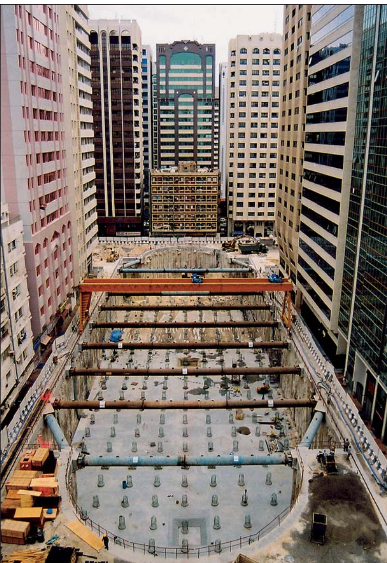
Baugrube für Tiefgarage in Abu Dhabi (unten)
