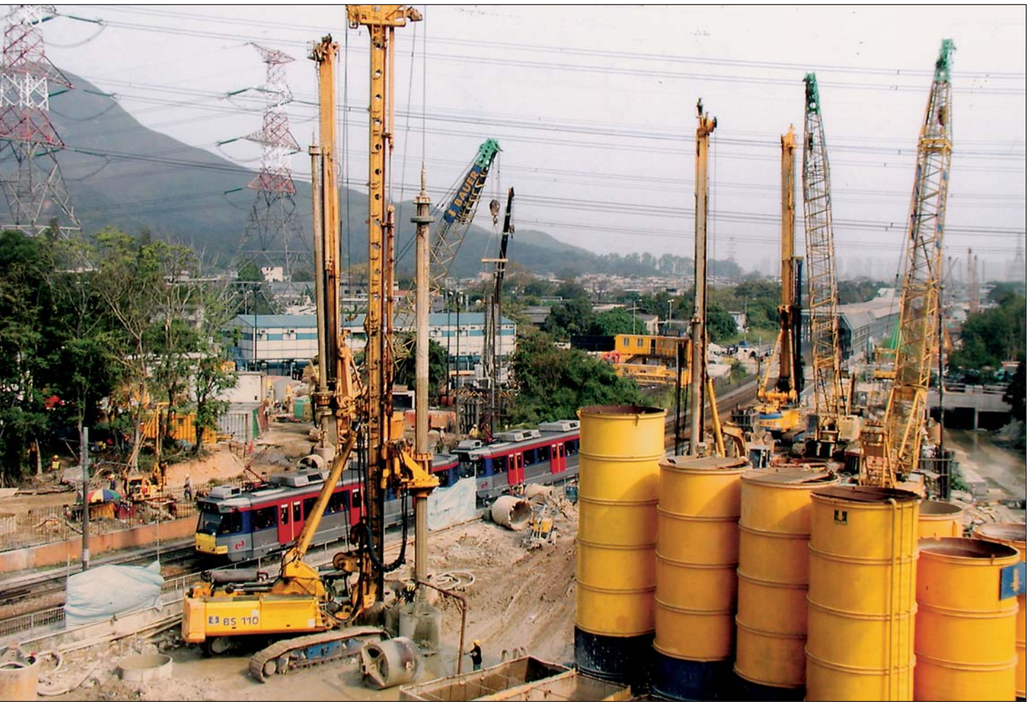
Bauer-Drehbohrgeräte wurden für die Gründungspfähle der Aufständigung eingesetzt.
