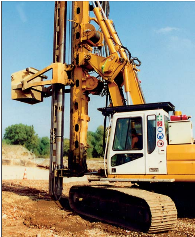
Bohransatz beim Tiefenrüttel-System
