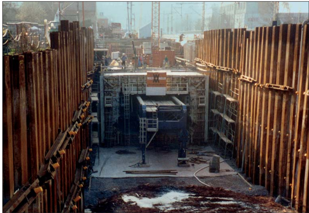
Tunnel in offener Bauweise: Ortsdurchfahrt Grötzingen
