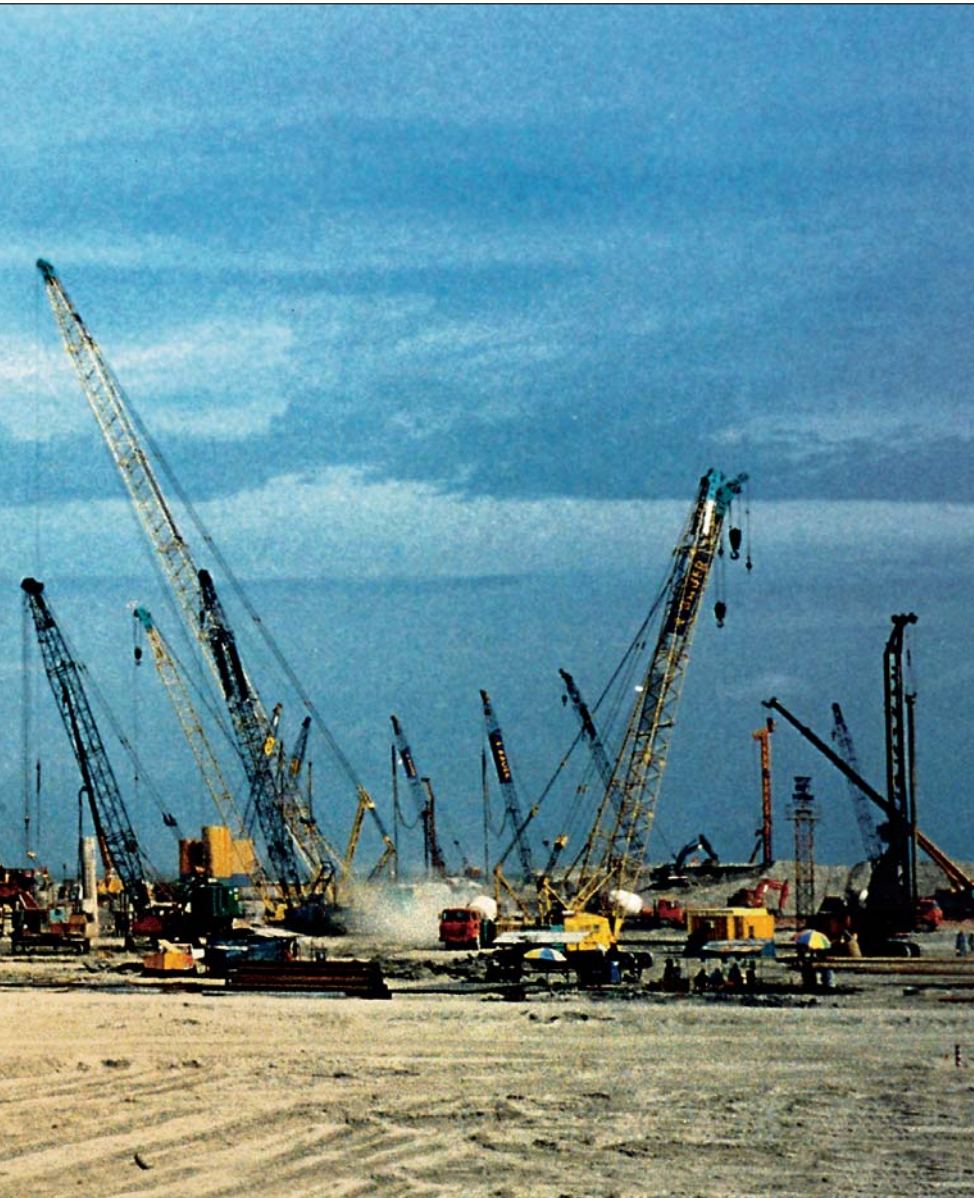
Erweiterung E.ON-Kraftwerk bei Jettenbach am Inn: Herstellung der Baugrube mit Bauer-Großdrehbohrgeräten
