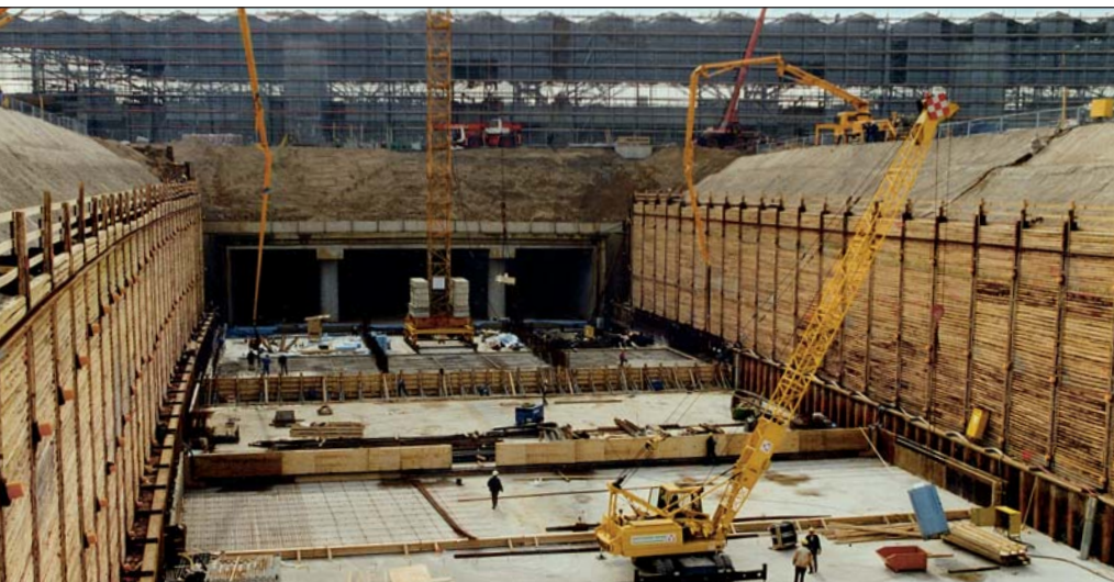
Tunnel in offener Bauweise – Köln Flughafenschleife
