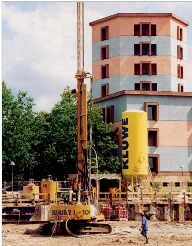
Herstellung einer Injektionssohle – Shell-Haus Berlin
