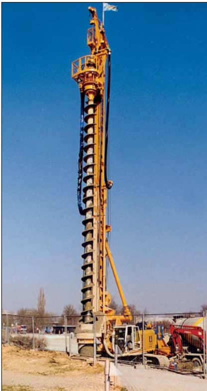
Endlosschnecke für das SOB-Verfahren
