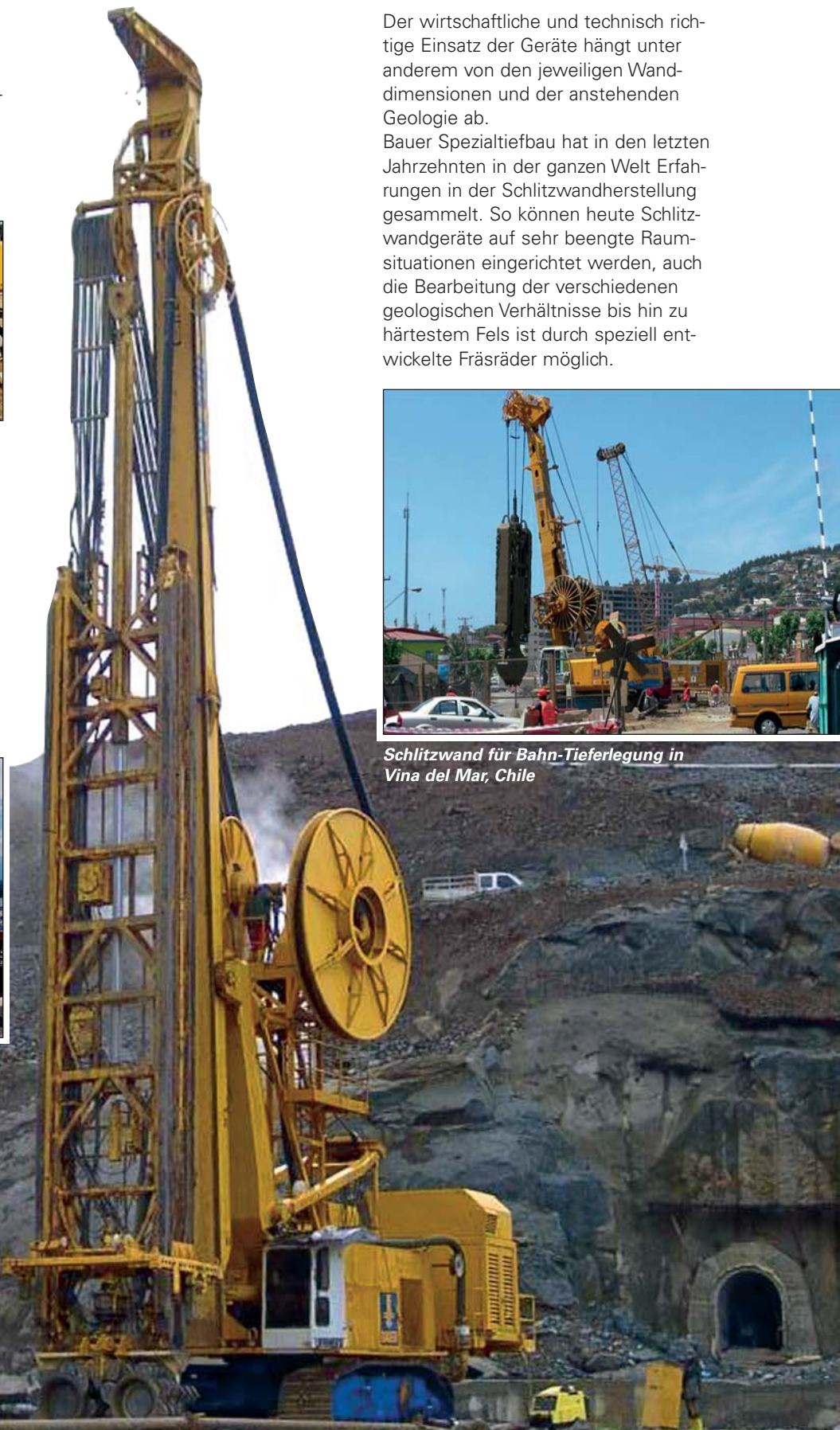
Bauer-Schlitzwandfräse BC 30 beim Bau der Schleuse Hohenwarthe
