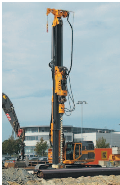
Предварительное разбуривание с RG 16 T Predrilling with RG 16 T (Germany)
