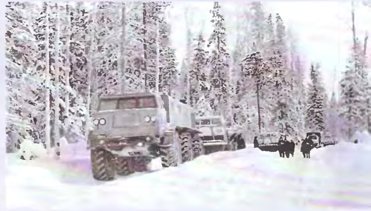
ЗИЛ-3167 на строительстве нефтепровода Шаим-Тюмень
