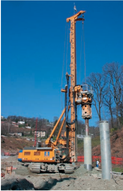
Kellyverfahren Kelly drilling system
