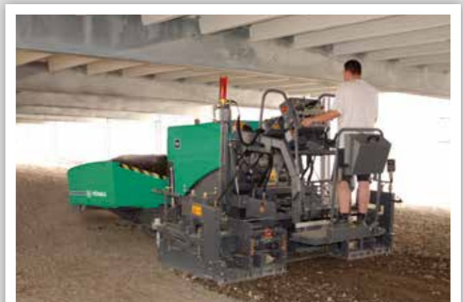
HERSTELLUNG DES UNTERBAUS FÜR PFLASTERSTEINE
