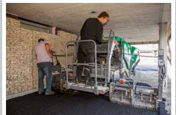
ASPHALTEINBAU IN INDUSTRIEHALLEN
