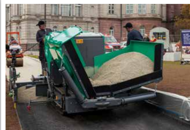
BAU VON RAD- UND FUSSWEGEN
