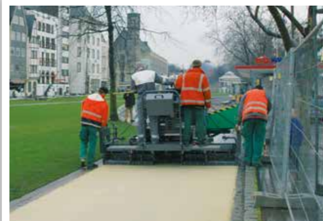
WEGEBAU IN PARKANLAGEN
