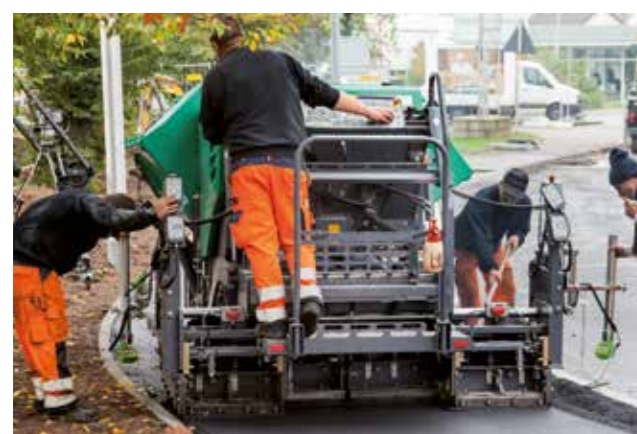
BAU VON WIRTSCHAFTSWEGEN
