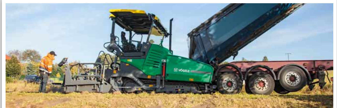
EINSATZ ALS KLASSISCHER STRASSENFERTIGER
