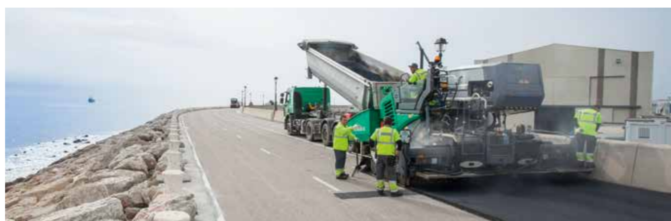
SANIERUNG EINER DAMMSTRASSE
