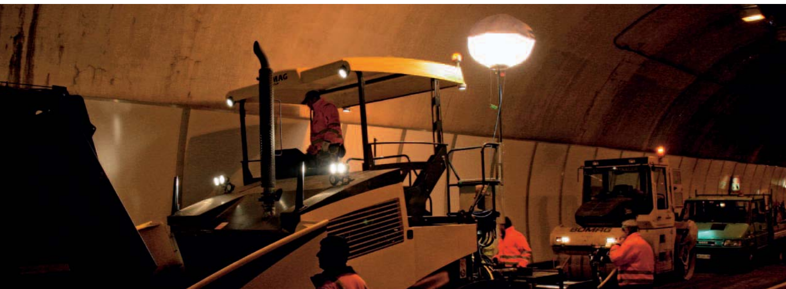
Ночные работы с ненаправленным освещением BOMAG и дополнительным освещением.
