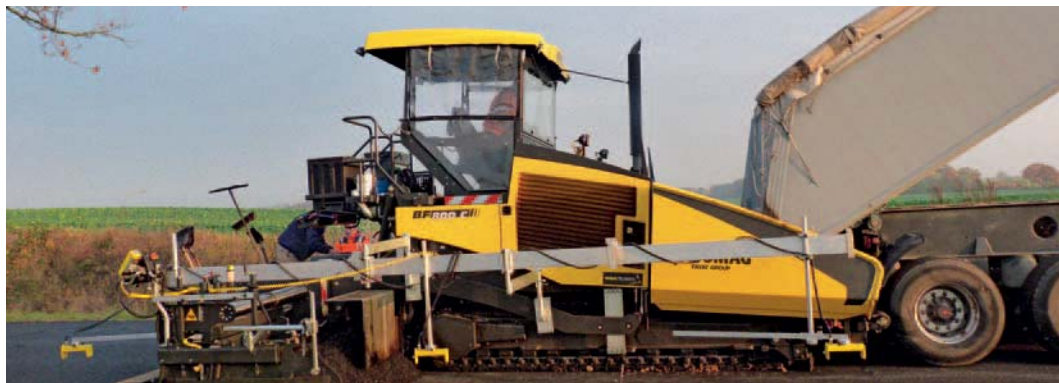
Укладка нижнего слоя асфальтобетонного покрытия с помощью нивелирующей системы Big Ski.
