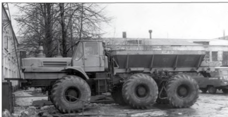
Машина для сплошного внесения удобрений и извести КСА-7 была разработана НИКТИМсельхозмаш и в особый период могла служить для обработки местности, зараженной болезнетворными микробами, или для дегазации
