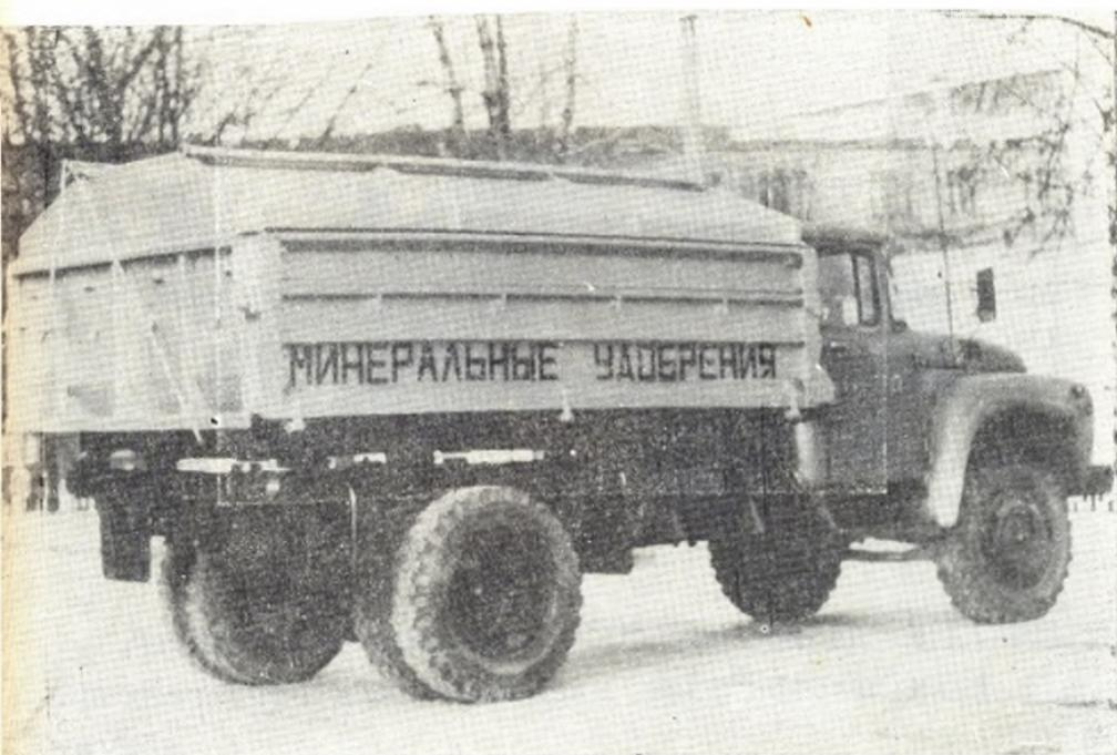
Предназначен для перевозки незатаренных минеральных удобрений. Платформа сборная из специальных прессованных алюминиевых профилей (с минимальным применением сварки), оборудована жесткой алюминиевой крышкой с открывающейся дверцей.
