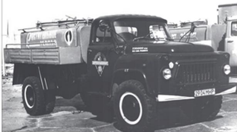
Автоцистерна для транспортировки живой рыбы АЦЖР-2,8-53, переоборудованная «Мосспрадтрансом» для перевозки растительного масла
