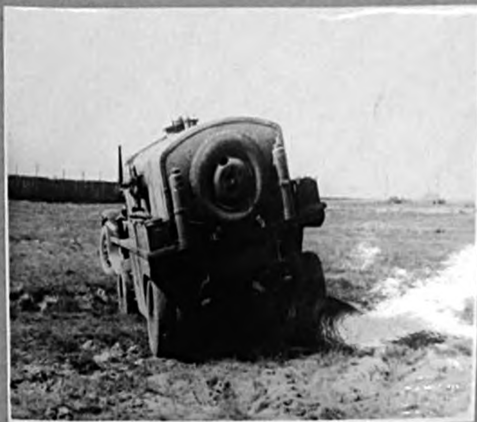
Фото № 18. Бензовоз преодолевает канаву длинною 2,5 метр. Канаву преодолел.
