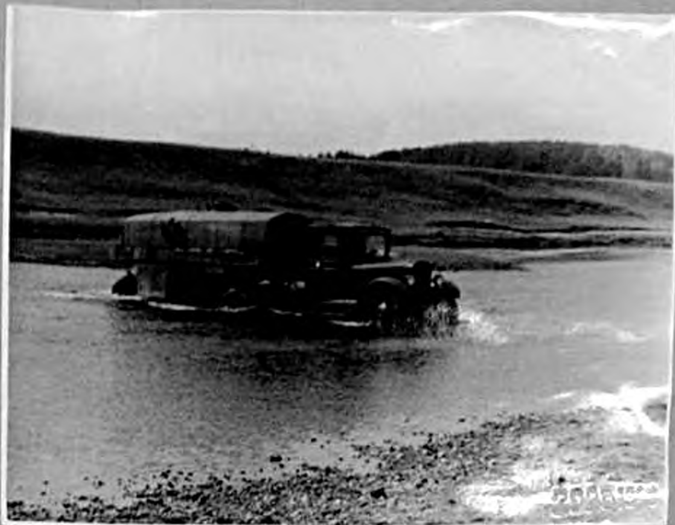
Фото № 13. Бензовоз преодолевает брод глубиной 0,5 м. Брод преодолен.
