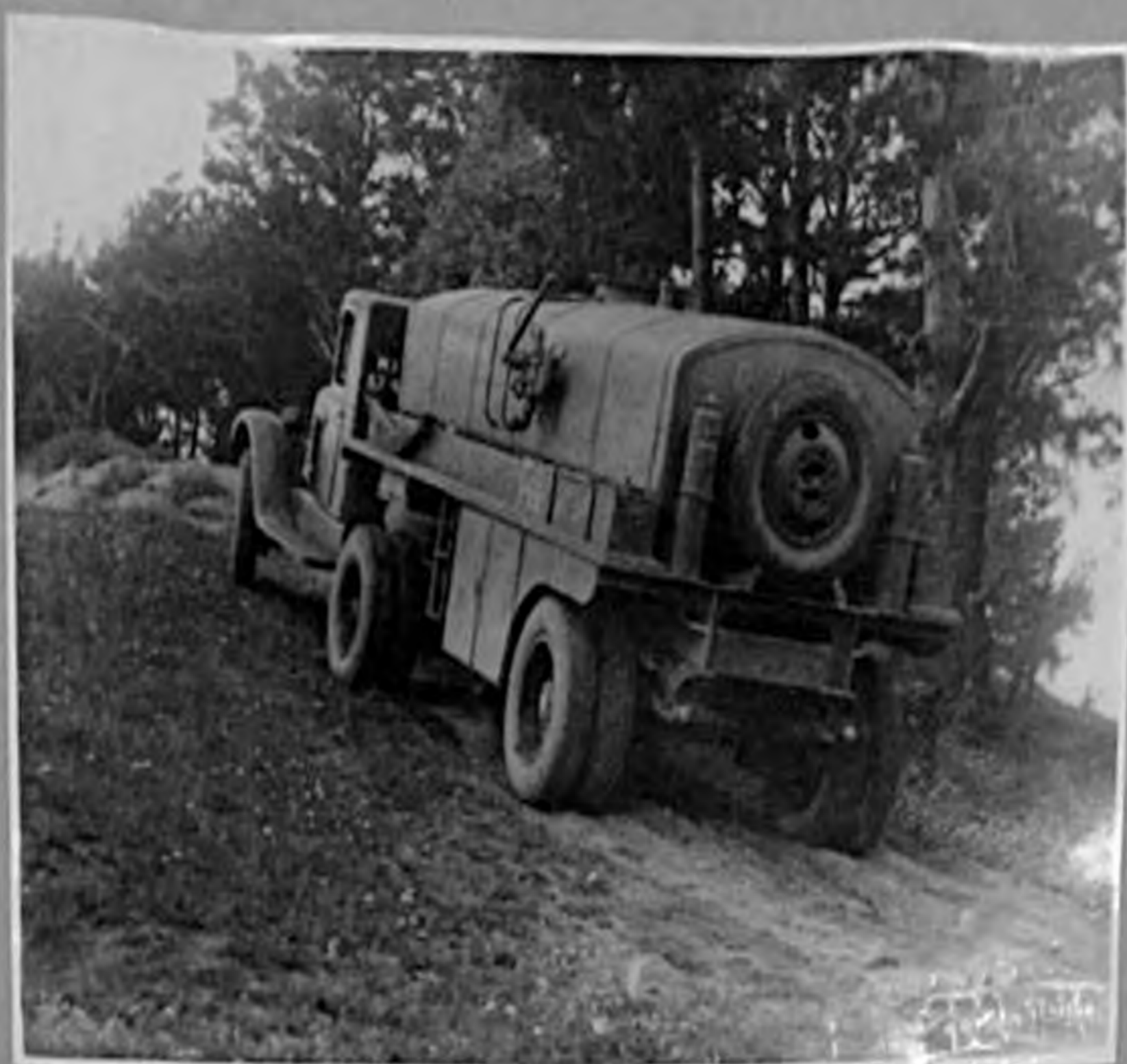
Фото № 14. Бензовоз буксует на подъеме 12,5^{\circ} на 20-ом метре. Подъем не преодолел.
