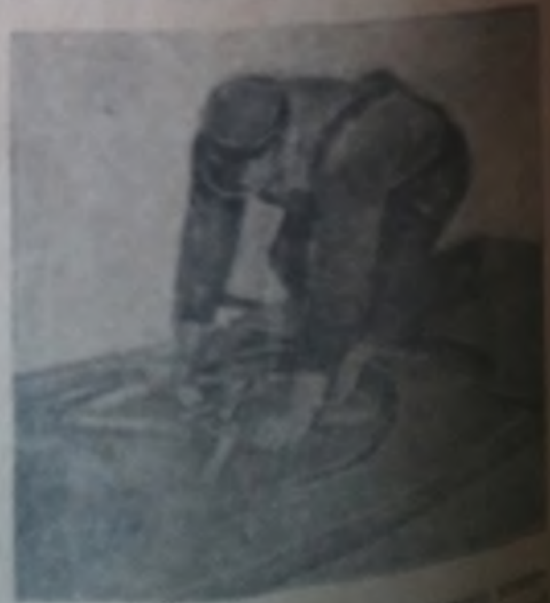
Рис. 2. Закрытие крышки грузовой части барабана бетоновоза
