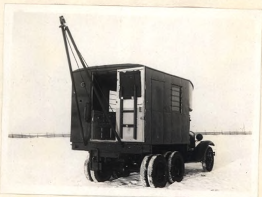
ФОТО № 7. ВИД ПОДЪЕМНИКА СВОКУ.
