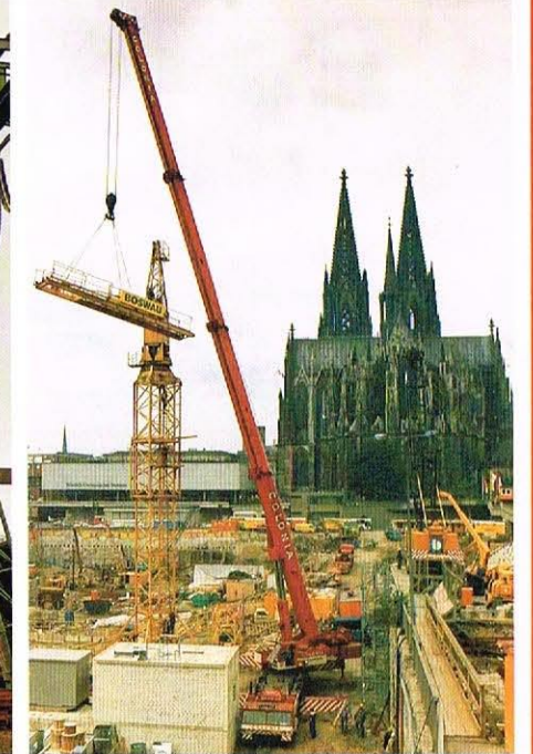
GOTTWALD AMK 200-83, 200/230 t Tragfähigkeit
